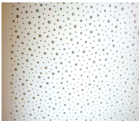
Figura 3.3 – Fotografia do teto acústico perfurado da sala SA 2.10.
