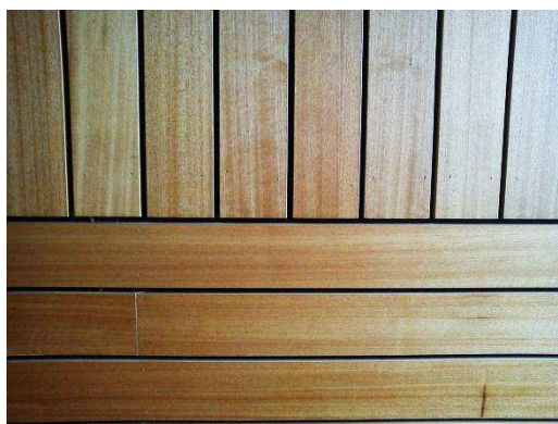
Figura 3.2 – Fotografia do ripado de madeira existente na parede do fundo da sala SE 4.3.
