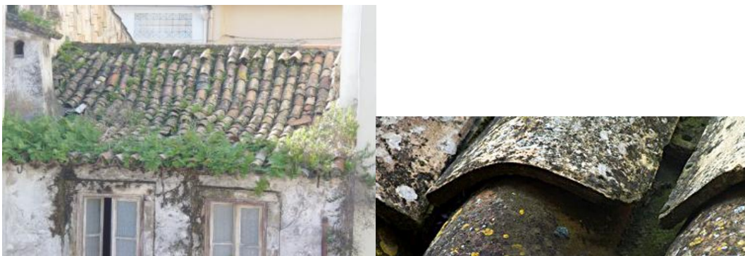
Figura 2.3 – Anomalias em coberturas inclinadas (Reprodução de (Mendes da Silva, 2009) e de (Ferreira, 2010)).
