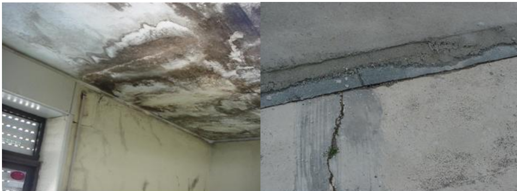
Figura 2.4 – Anomalias em coberturas planas (Reprodução de (Mendes da Silva, 2009))
