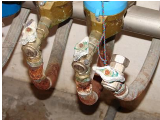
Figura 3.5 – Corrosão bimetálica (Adaptado de (Paiva et al., 2006)).
