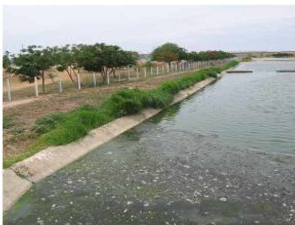
Figura 4.5 - Materiais flutuantes na bacia de oxidação. (Imagem obtida pelo autor)
