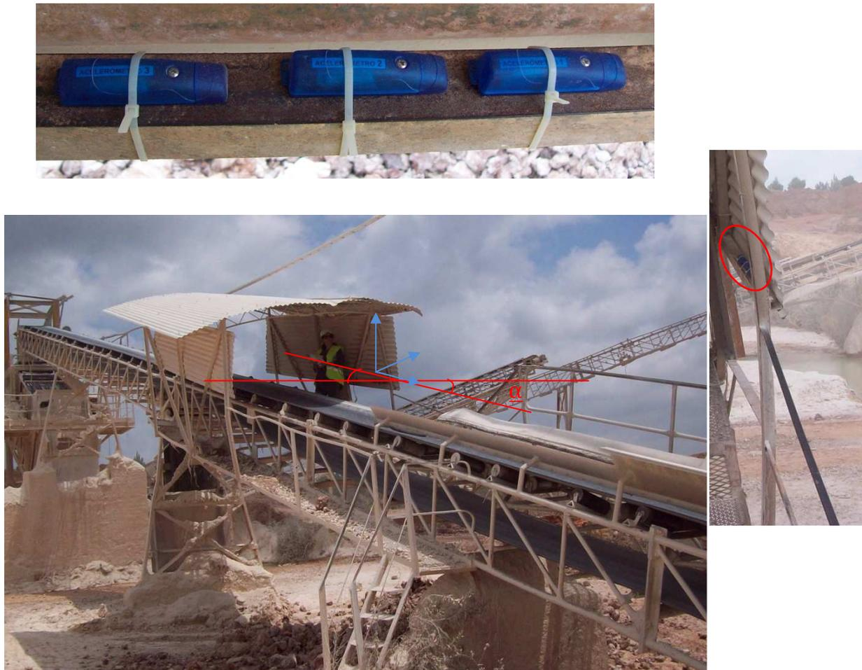
**Figura 20 - Colocação dos acelerómetros no posto tapete**
