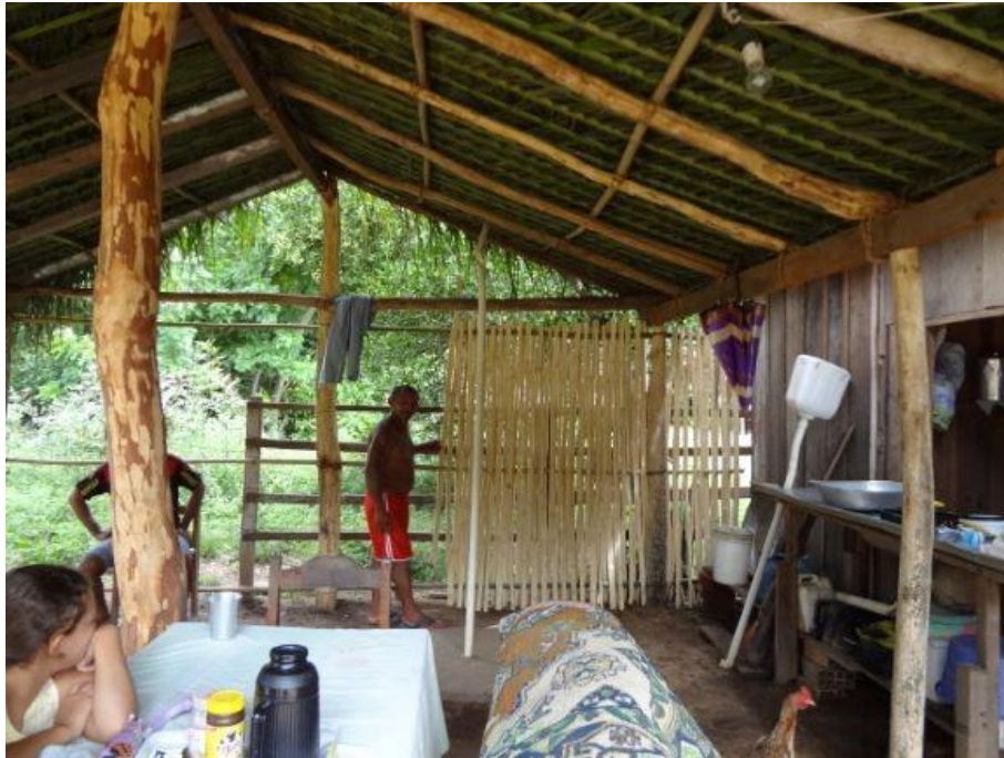
Imagem 17: Morador a construir uma nova cozinha para a casa
