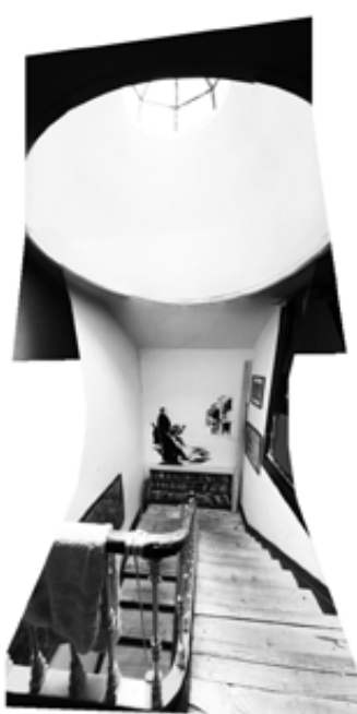
Fotografia das escadas
