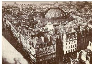
Figura 1. Vista panorâmica do quarteirão da Halle au Blé, por volta de 1885, sendo visível a cobertura com danos decorrentes de incêndio em anos anteriores.
