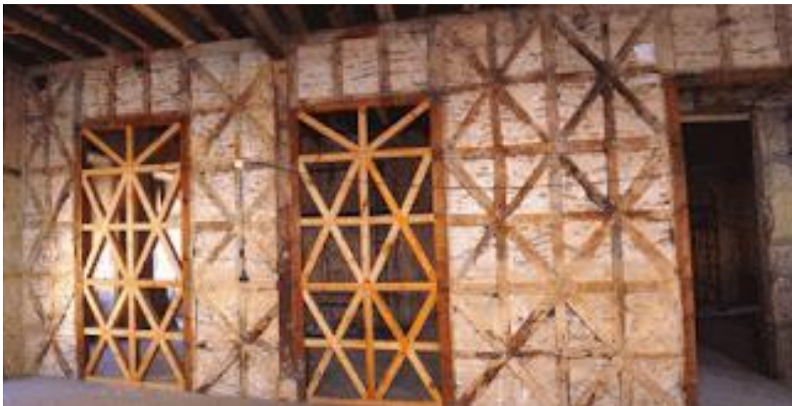
Figura 2.3 - Parede de edifício Pombalino. Fonte: ECOCASA (2018).
