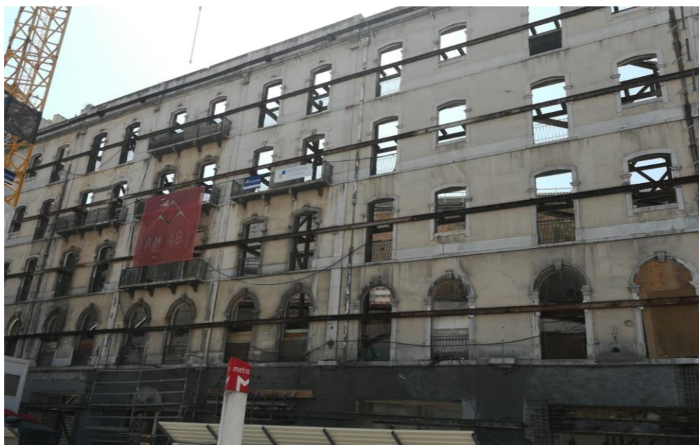
Figura 2.6 - Edifício localizado na Avenida da Liberdade, Lisboa – 2018.
