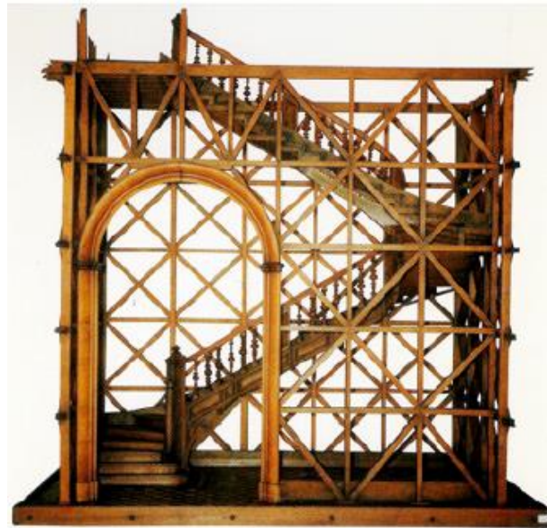
Figura 2.2 - Estrutura da Gaiola Pombalina. Fonte: Lopes e Bento (2005).
