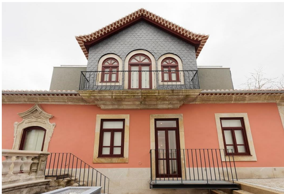
Figura 4.28 – Fachada da Casa das Bocas remodelada: Fonte: Município de Viseu (2022).
