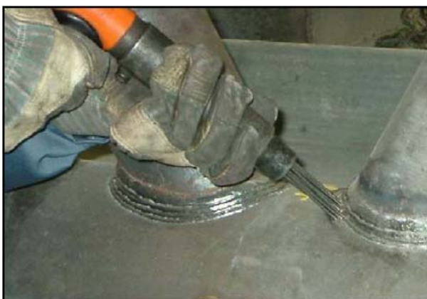
Fig. 11 application de la méthode de parachèvement par martelage par aiguilles
