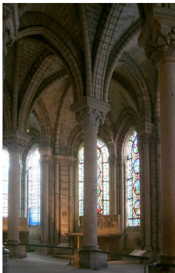
Fig.48 Ambulatório da Basílica de St. Denis com grandes vãos de vidro colorido.
