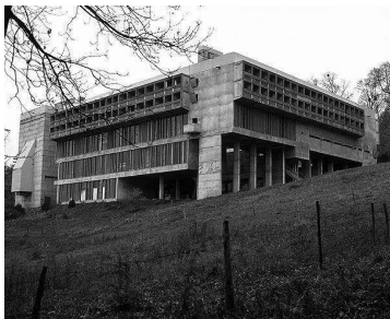
Fig.170 Fachada Oeste e Sul.
