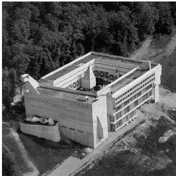
Fig.169 Fachada Norte e Oeste.
