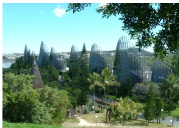
Fig.97 Vista da entrada através de trilhos
