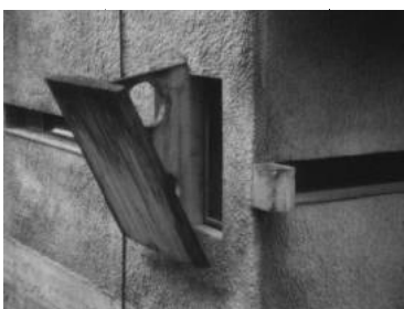
Fig.181 Vista exterior da “flor de betão” localizada no final do corredor.
