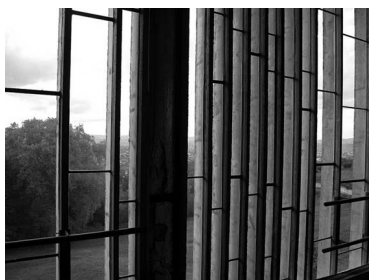
Fig.177 Ondulatórios no refeitório.
