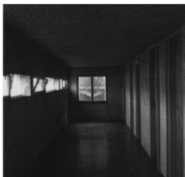
Fig.180 Corredor das celas com aberturas horizontal e a “flor de betão” no final.
