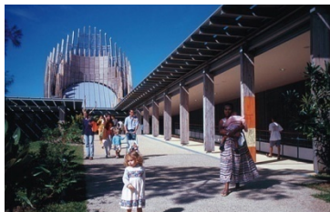
Fig.98 Circulação exterior do auditório.
