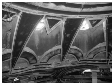
Fig.55 Detalhe da entrada de luz pela cúpula.
