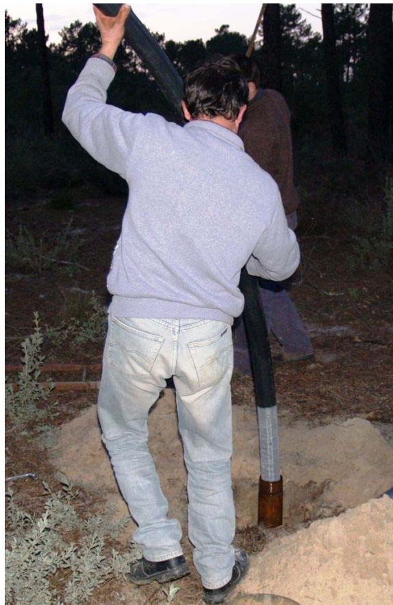
Figura 1.8 – Imagem da colocação do piezómetro.
