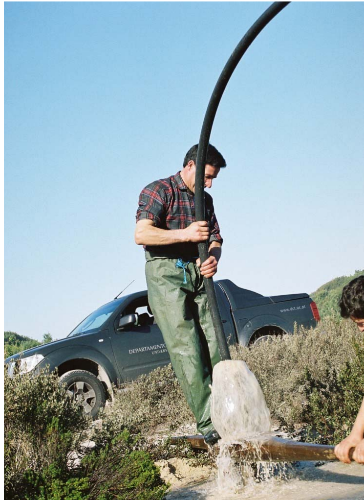
Figura 1.6 – Injecção de água no furo.
