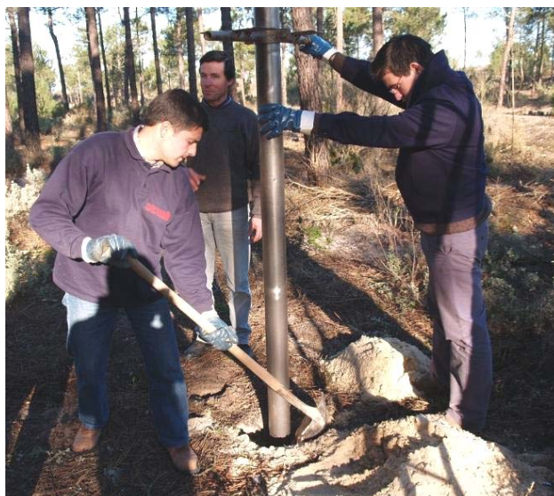
Figura 1.3 – Colocação do tubo de revestimento em aço.
