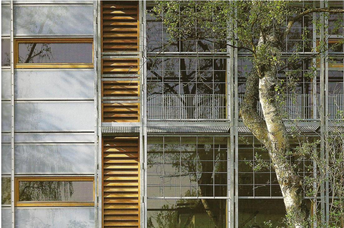
FIG. 24: Edifício de escritórios, Munique (1994). Arquitecto Thomas Herzog. Primeira construção de fachada com aerogel granulado.
