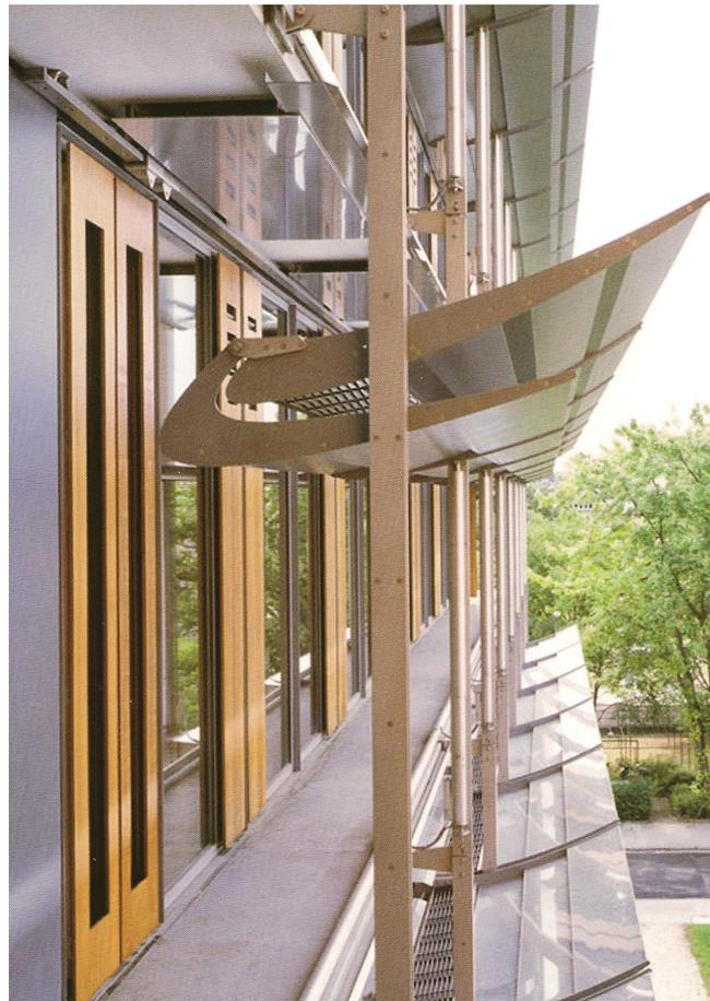
FIG. 39: Edifício de administração de Wiesbaden, Herzog e Partners. De cima para baixo, da esquerda para a direita: Conjunto de escritórios. Sombreamento da fachada sul: 1-Sombreamento de radiação directa, 2-Sombreamento em dias nublados, 3- Ventilação natural controlada e regulada, 4- Ventilação livre com aberturas. Pormenor do sistema de sombreamento.
