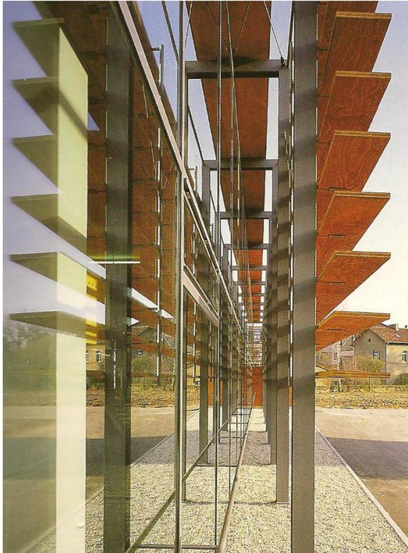
FIG. 37: Biblioteca pública, Landau (1998), arquitectos Lamott. Uma rígida grelha de madeira montada em frente à fachada de vidro proporciona sombreamento
