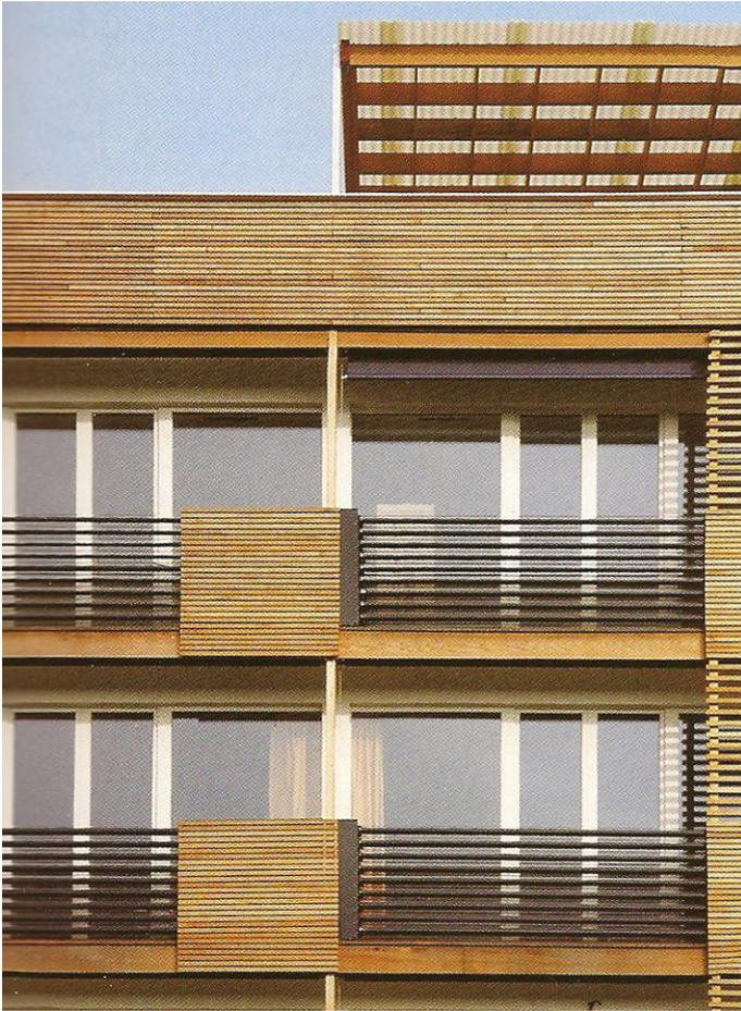
FIG. 47: Complexo Habitacional em Zurique, 2001, arquitectos Beat Kampfen. A balastrada da varanda é composta por colectores de tubo vácuo.
