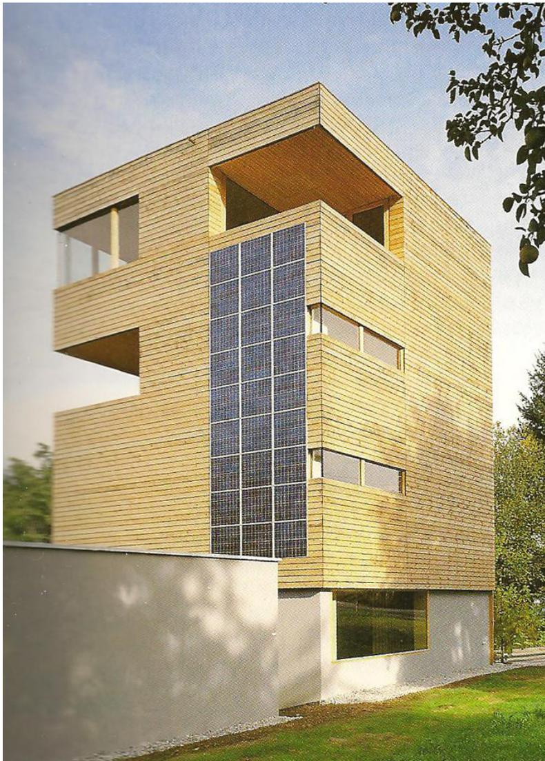
FIG 66: Habitação de baixo consumo energético em Bregenz, de Daniel Sauter, 2001. O sistema de painéis fotovoltaicos está estruturalmente e esteticamente integrado na fachada.
