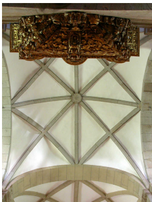
9. Abóbada da nave central de Miranda
