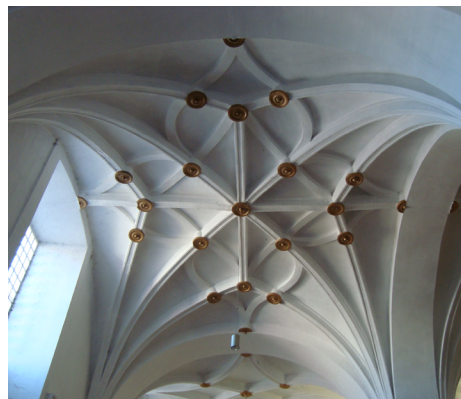
11. Abóbada da nave central de Portalegre
