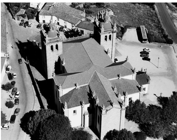
5. Vista aérea da Sé de Miranda do Douro. As volumetrias da cabeceira (pouco mais de dois tramos) e transepto (um tramo) juntas chegam a ser mais compridas que a do corpo das naves (três tramos).
