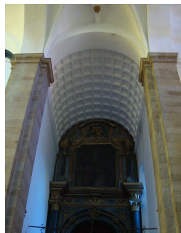
16. Cobertura das capelas laterais na Sé de Portalegre
