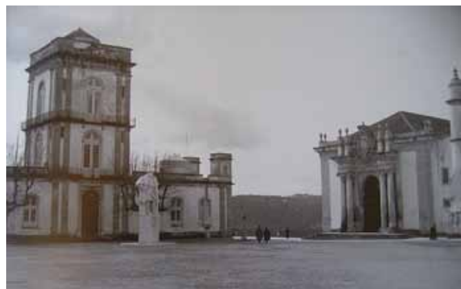
3 - Fotografia antiga do edifício do Observatório Astronómico da Universidade de Coimbra, em frente à Biblioteca Joanina, que foi demolido no tempo de Salazar.
