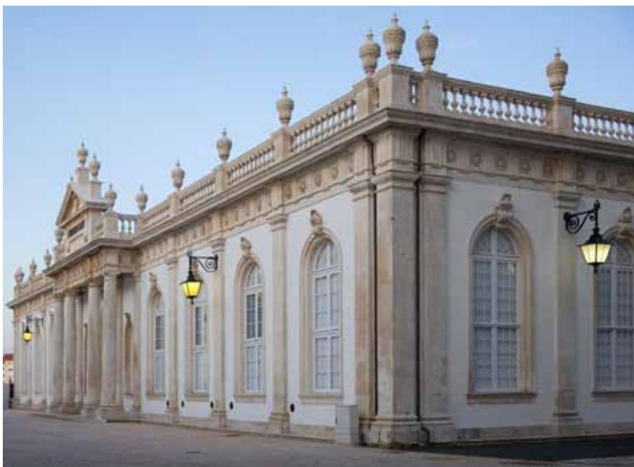
1 - Edifício do Laboratório Chimico, actual sede do Museu da Ciência da Universidade de Coimbra. O edifício original do engenheiro inglês William Elsdon, que aproveitou o espaço de um antigo refeitório jesuíta, foi restaurado pelo arquitecto João Mendes Ribeiro e colaboradores.
