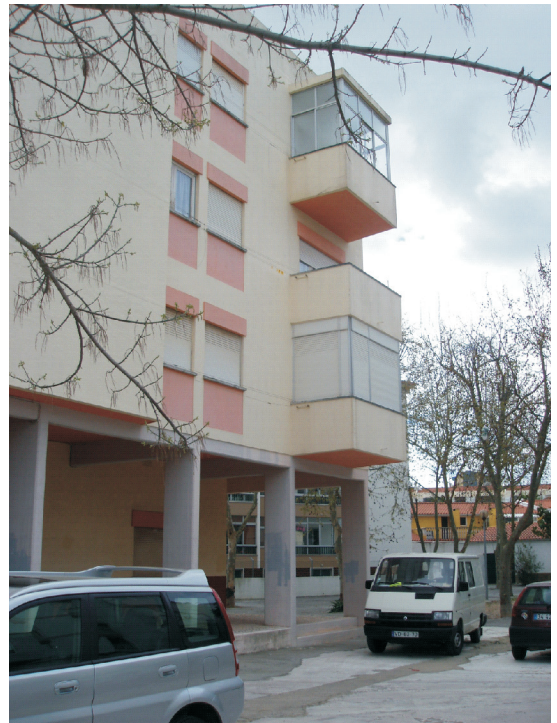
Fot. 1 - Alapraia, São João do Estoril. Às 23h 30m de 25 de Novembro de 1967 este prédio encontrava-se rodeado de água até 1,5 m de altura.
