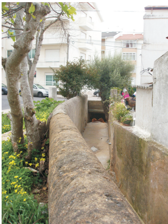
Fot. 4 - Alapraia, São João do Estoril. Encanamento da valla junto à casa da fotografia anterior. Ao fundo, brusca passagem a túnel por baixo da rua.
