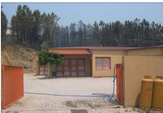
Rot. 8 - Estabelecimento de ensino confinante com área florestal sem faixa de proteção exterior.
