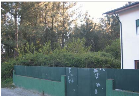
Rot. 6 - Casa confinante com área florestal sem faixa de proteção exterior.
