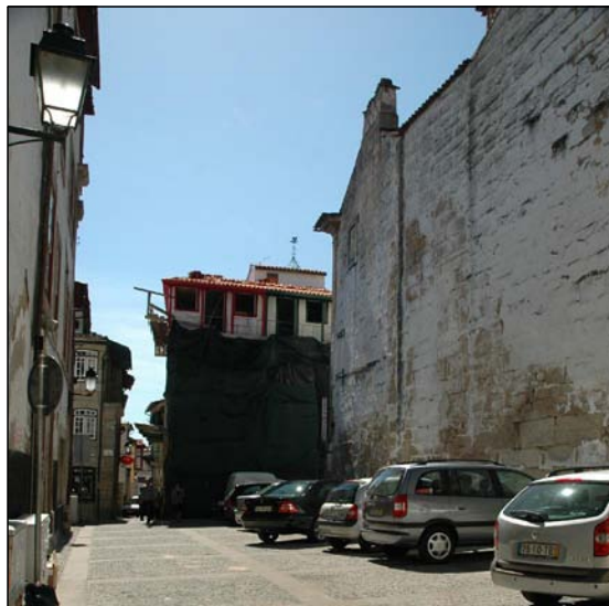
Fig. 6 Fotografia da área correspondente ao edifício demolido
