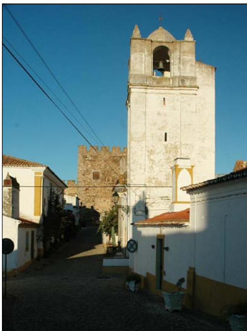
Rua principal e porta do castelo
