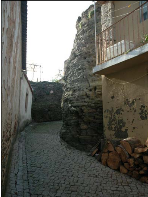
Porta de Nossa Senhora dos Remédios (cortina Nascente da cerca medieval)
