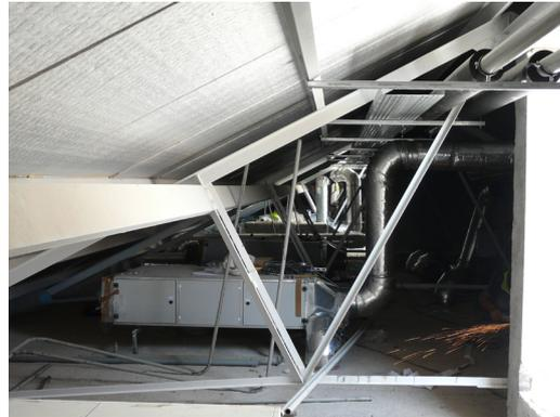
**fig. 105 | Máquinas AVAC (desvão da cobertura)**
