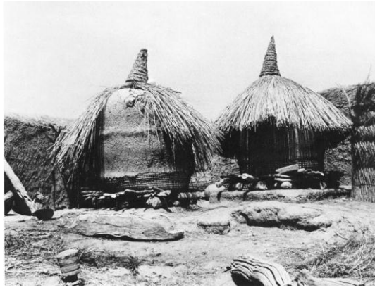
Imagem 20 – Construções Indígenas no Mali. Volumes de forma circular protegidos por cobertura em palha.
