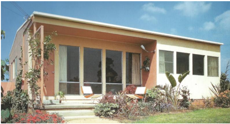
Imagem 48 – Casa segundo sistema Packaged House de Walter Gropius e Konrad Wachsmann
