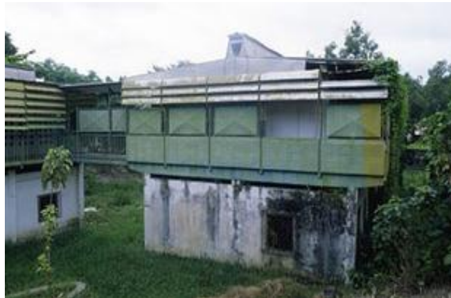
Imagem 32 – Casas em Brazzaville sobre volumes de alvenaria.
