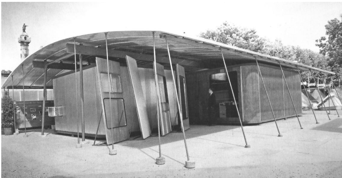
Imagem 46 – Na Casa Sahara, construída em 1958, Jean Prouvé repetiu o mesmo princípio concetual de uma grande tenda metálica a abrigar volumes habitáveis. Contudo, conforme é possível ver na imagem, são acrescentados equipamentos elétricos de ventilação.
