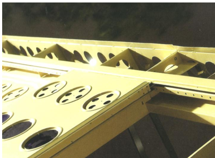
Imagem 39 – Viga sobre painéis modulares perfurada ao máximo de forma a pesar o menos possível
