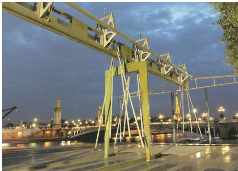
Imagem 84 – Reconstrução de uma das Casas em Brazzaville junto ao rio Sena em Paris. Nesta imagem podemos ver as partes que compõem a viga central em forma de espigão e todo o esquema de apoio da viga central nos topos das habitações.
