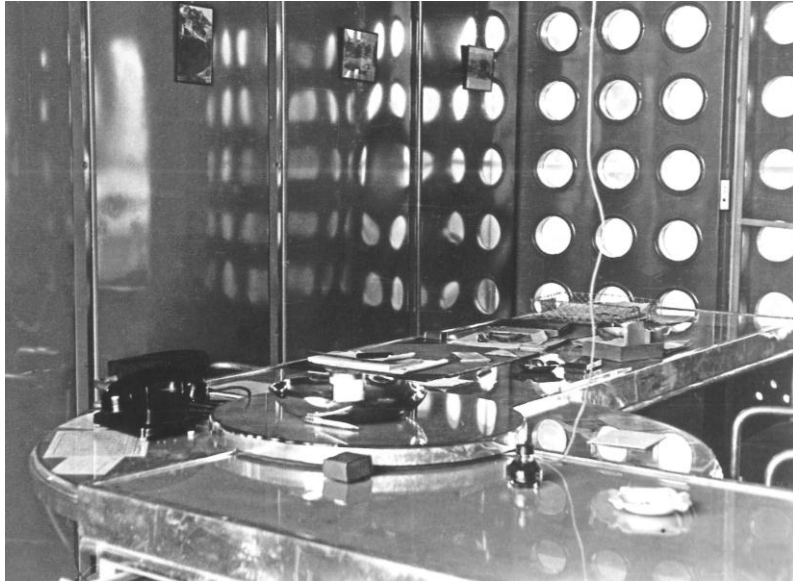
Imagem 74 – Interior da Casa em Brazzaville. Os painéis modulares e os móveis são em alumínio.
