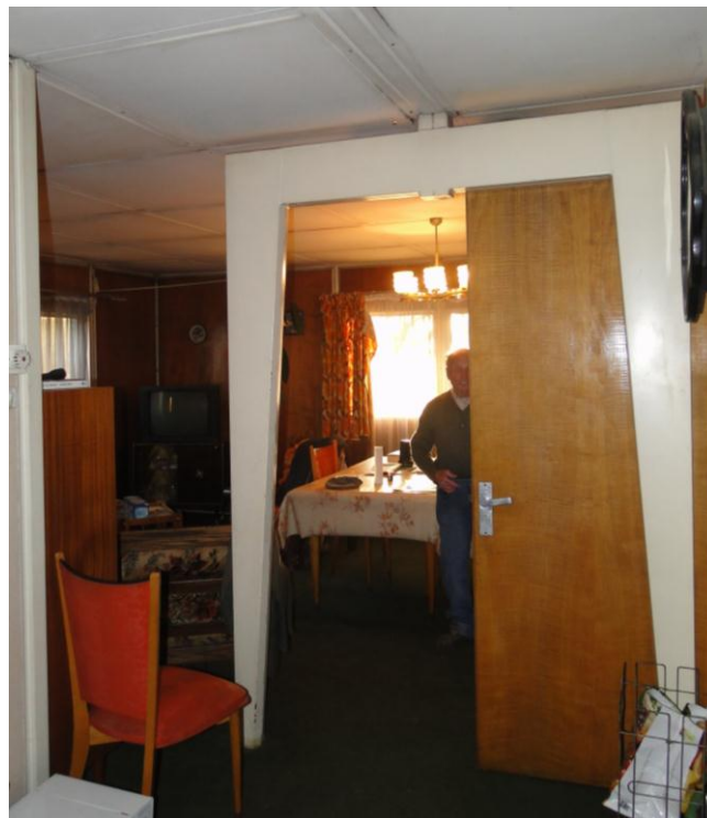
Imagem 75 – Interior da habitação nº14 em Meudon que tivemos oportunidade de visitar. Embora alguns painéis sejam revestidos a madeira no interior a imagem geral é de uma protótipo composto por painéis em alumínio e elementos estruturais em aço.
