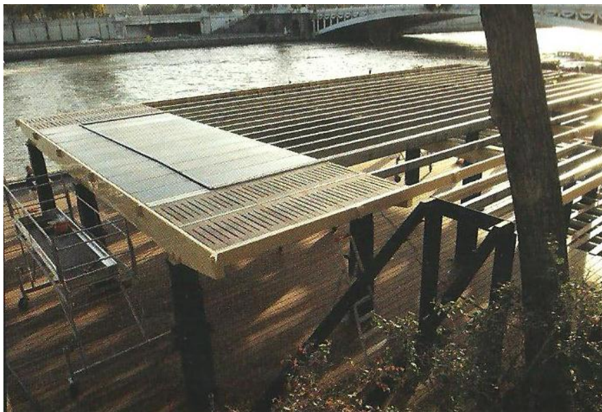
Imagem 88 – Na reconstrução de uma das Casas em Brazzaville junto ao rio Sena em Paris podemos ver as contra-vigas longitudinais sobre as quais pousam os painéis do pavimento: os módulos em aço de 3x0,5m e os módulos em madeira de 1x1m.
