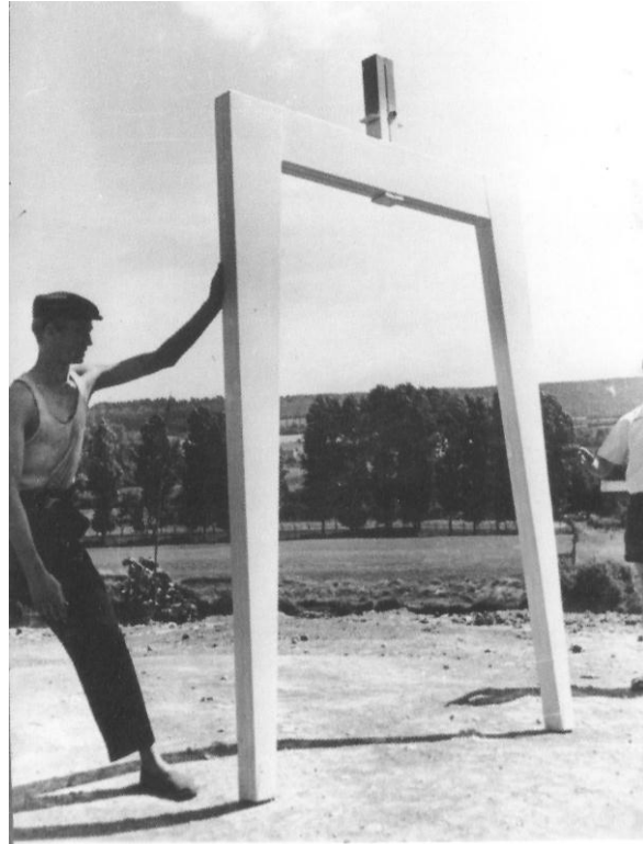
Imagem 78 – Elemento tipo Pórtico Central construído na fábrica de Jean Prouvé, em Maxéville.
