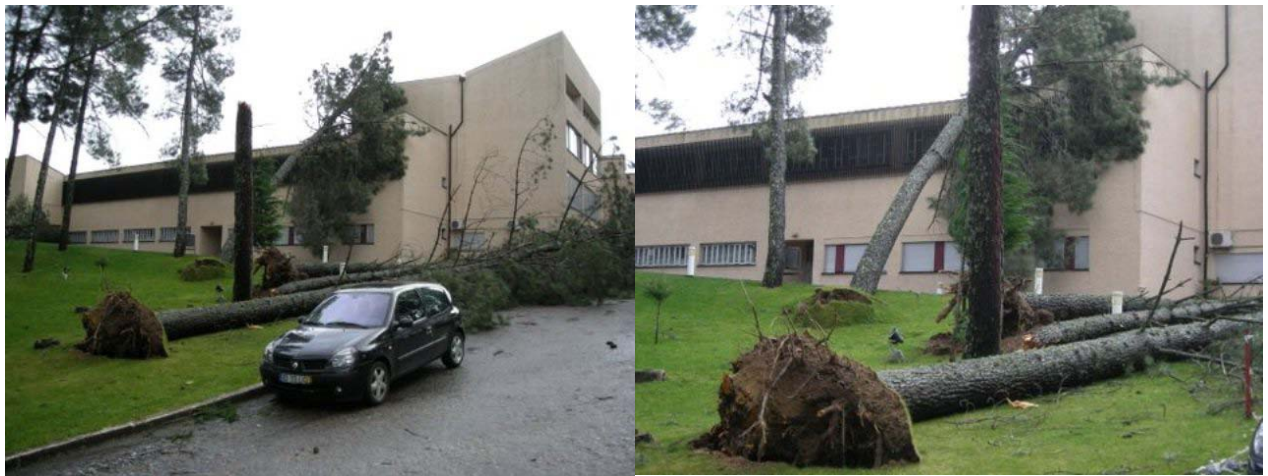
Figura 22 e 23 – Queda de árvores devido a vento forte junto ao Complexo Desportivo de Lamego em Janeiro de 2009 (Fonte: Fotos tiradas por Rui Pires)
