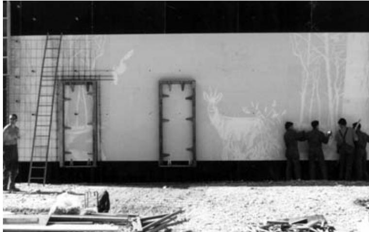
Imagem 103. Processo da gravação no betão durante a moldagem *in situ*
