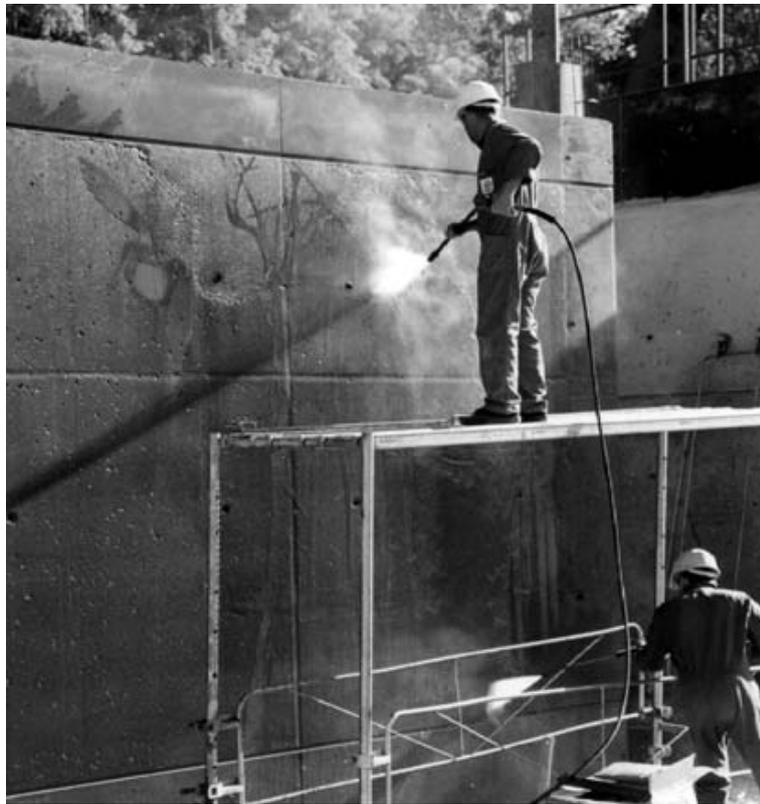
Imagem 104. Processo da gravação no betão durante a moldagem *in situ*
