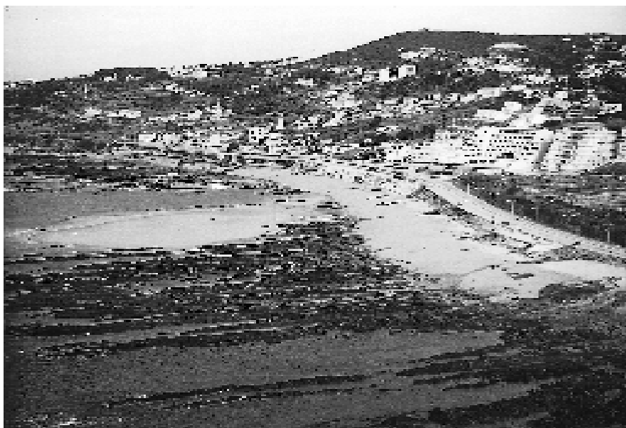
Foto 6 - Panorâmica aérea do troço litoral entre o Cabo Mondego e o cemitério de Buarcos, na baixa-mar de maré viva, evidenciando a grande exposição do substrato rochoso e os trabalhos de reparação do enrocamento da avenida marginal. Note-se que grande parte da escassa cobertura de areia que é visível se acumulou durante um curto período (1ª semana de Janeiro de 1998) com forte ondulação de NW (atingiu cerca de 5 m de altura, ao largo). No lado direito da fotografia observa-se a extremidade NW da área onde se executam trabalhos de loteamento para a construção de uma densa frente edificada junto da marginal.
