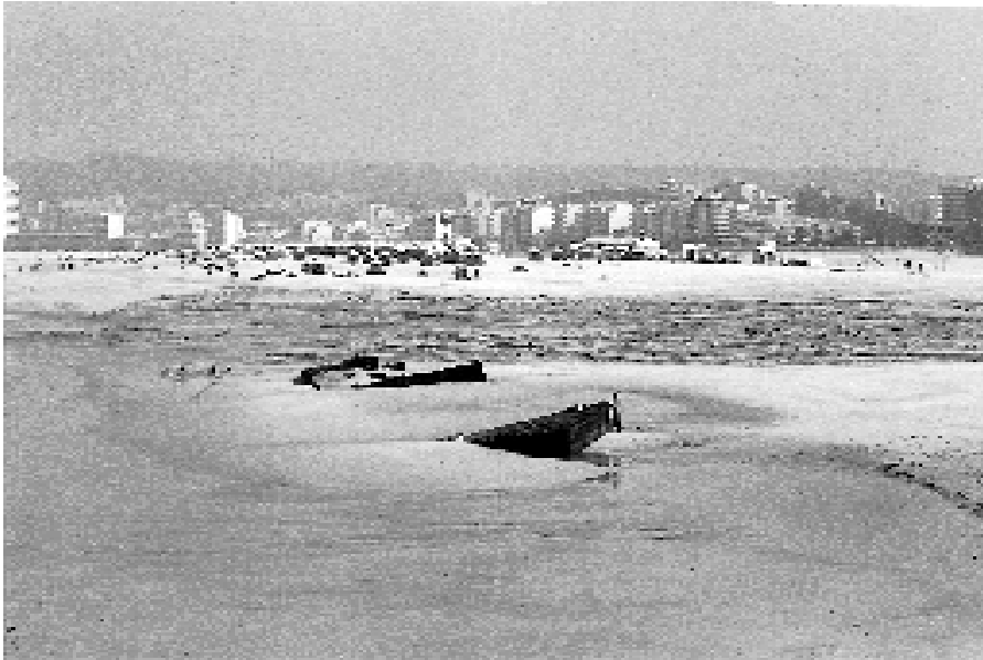
Foto 3 - A extração de areia na praia da Figueira da Foz (junto do molhe norte) gerou uma enorme depressão, com rebaixamento em cerca de 8 m, expondo um barco soterrado durante 32 anos.
