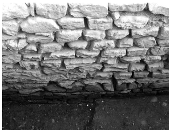
Fig. 14 – Parte do alçado da grande estrutura
