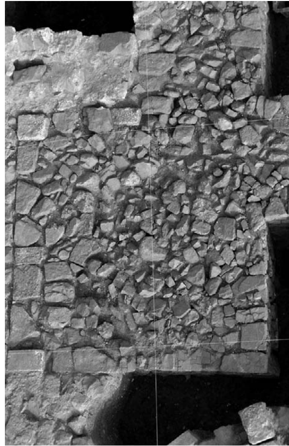
Fig. 5 – Pormenor da torre quadrangular
