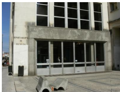
Imagem 6 – Fotografia do Departamento de Química.
