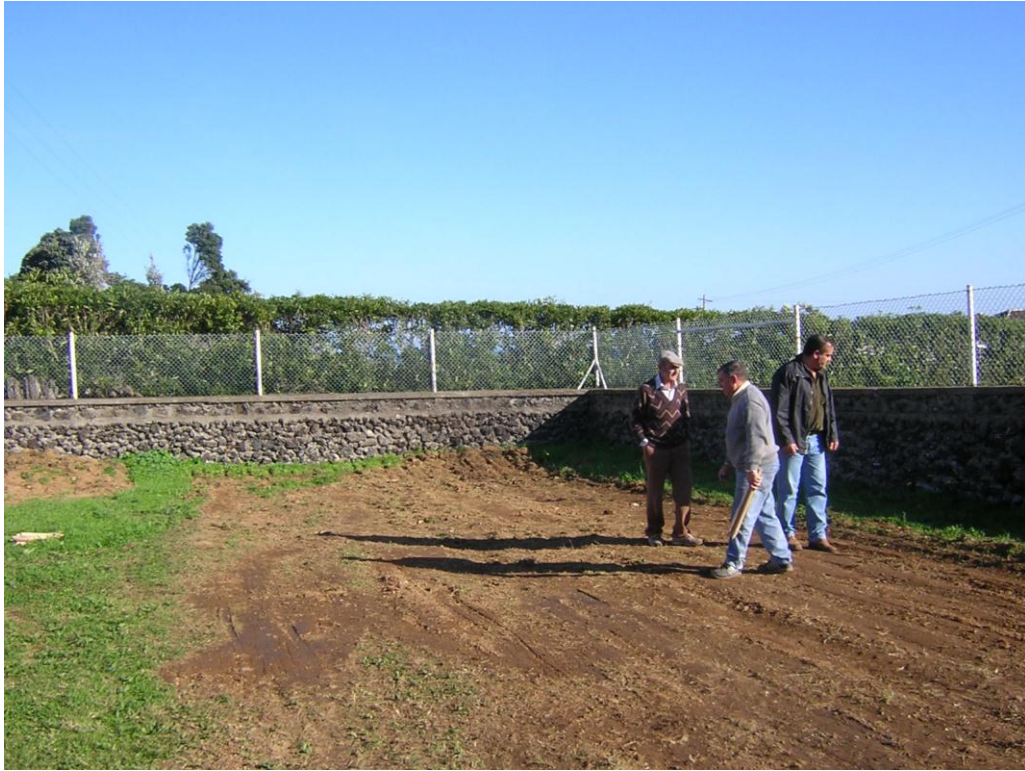
Limpeza e terraplanagem do local de construção
