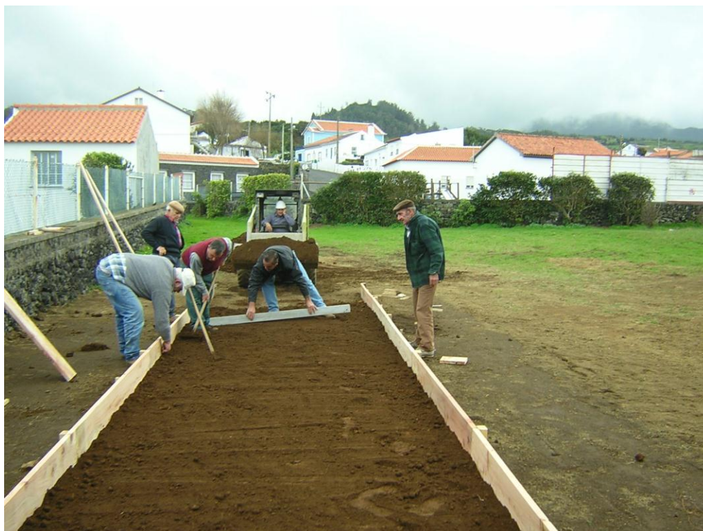
Aplicação da ultima camada de terra argilosa e respectivo nivelamento para posteriormente ser batida
