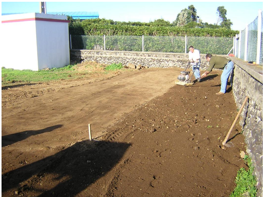
Batimento da terra argilosa para formar uma base tipo tijolo, compacta.
