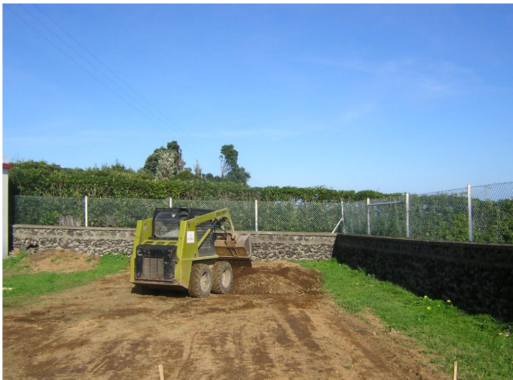
Aplicação de terra argilosa para formação da base da área de jogo
