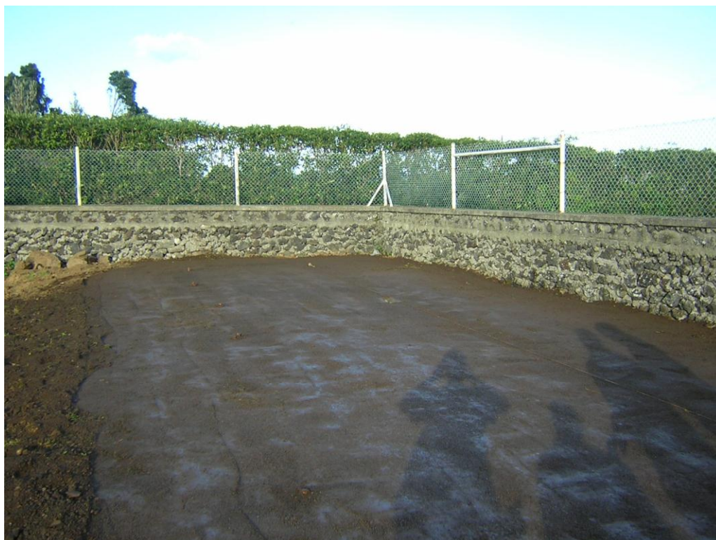
Base do área do jog, devidamente compactada e aplanada
