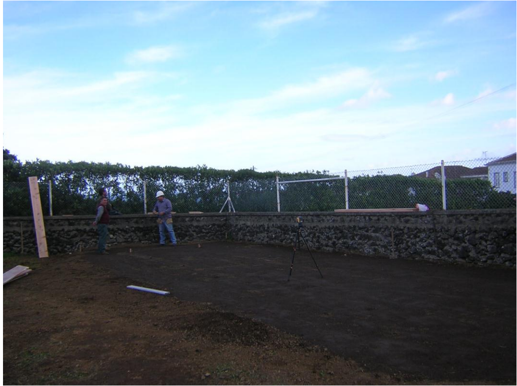
Nivelamento da base da área de jogo
