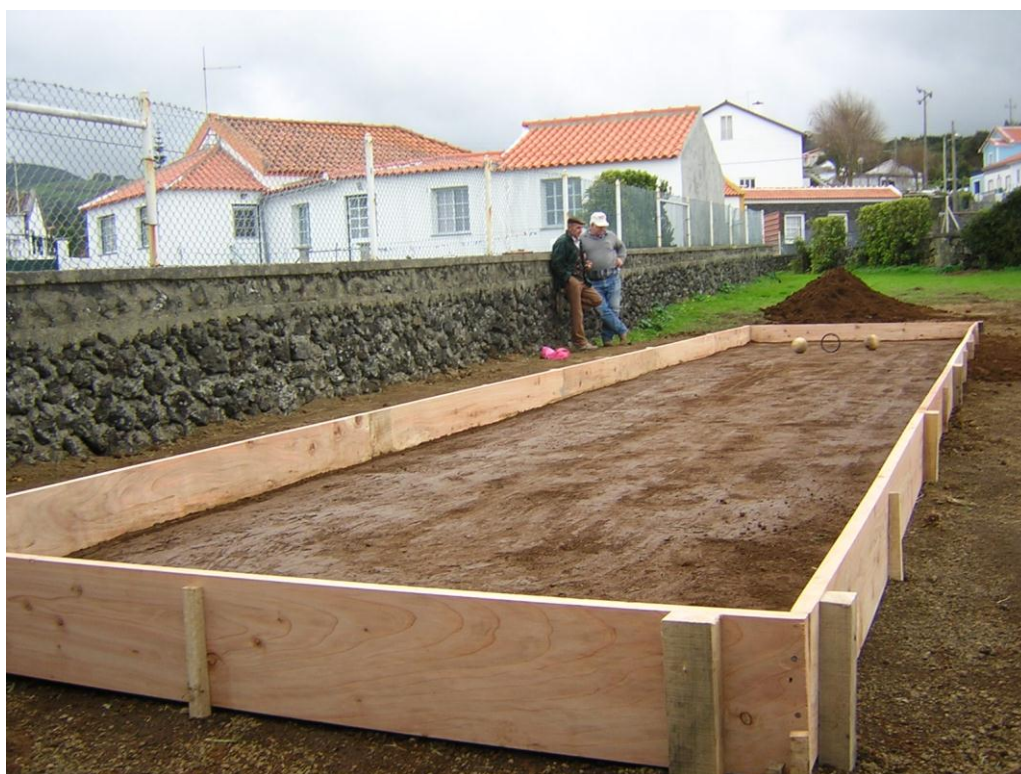
Espaço de jogo terminado devidamente delimitado com uma base de terra argilosa batida, plana e lisa.
