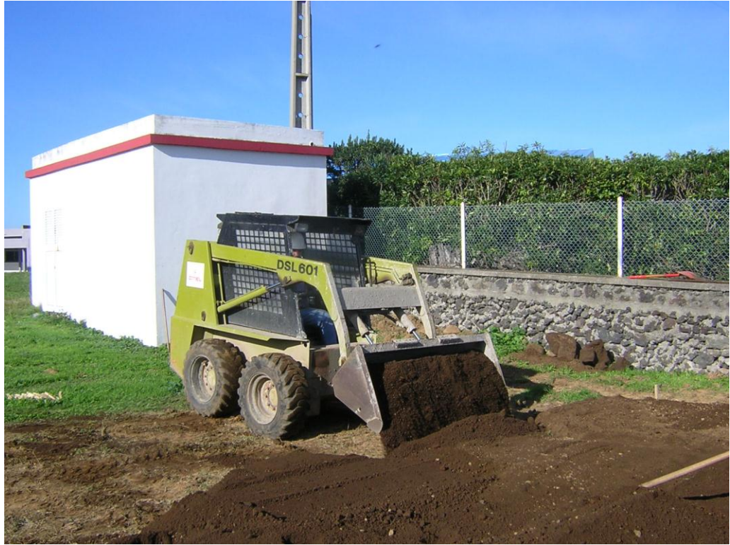
Aplicação de varias camada de terra argilosa na base da área de jogo
