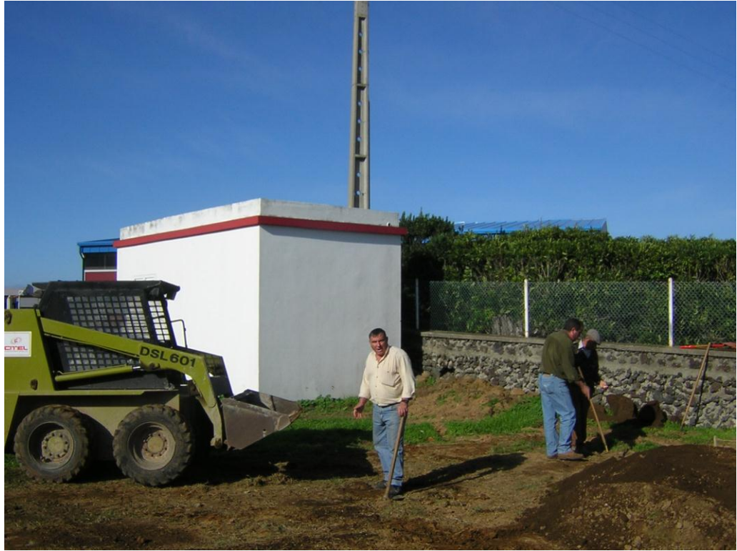
Terraplanagem da terra argilosa
