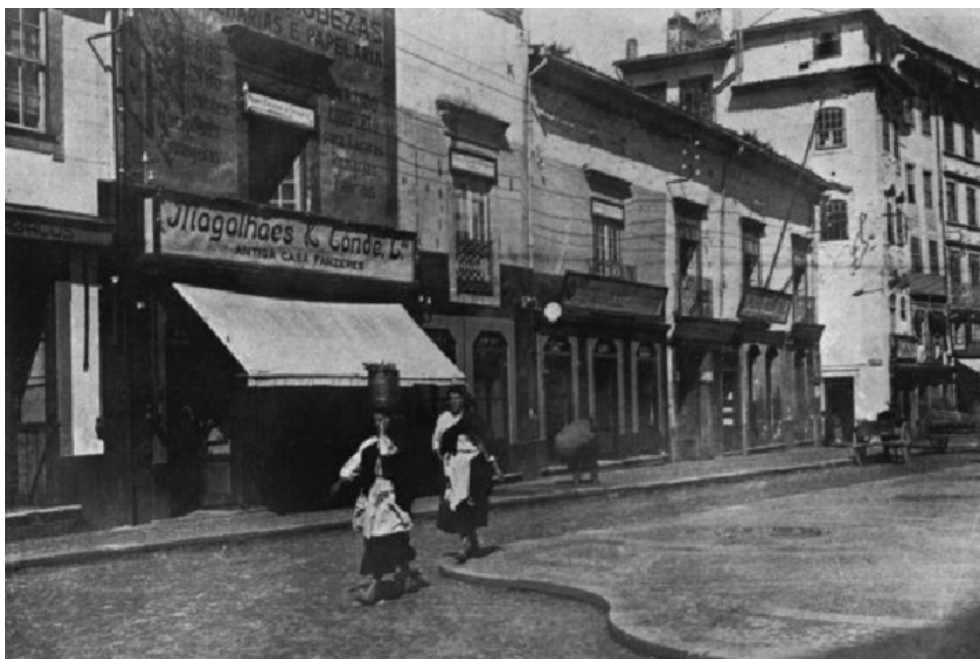
Imagem 21 - Edifício do antigo Hospital antes de ser acrescentado em 2 pisos
