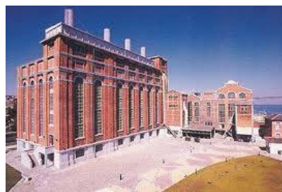
Figura 7 – Museu da Electricidade em Lisboa.
