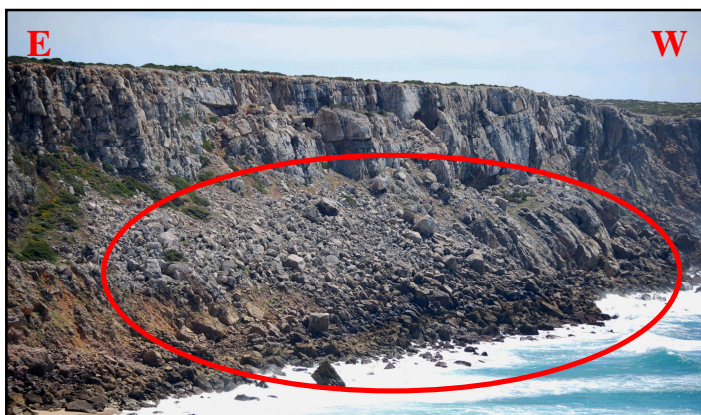
Figura IV28 – Fotografia de um desmoronamento (limitado por um círculo vermelho) observado numa das arribas costeiras da Praia do Telheiro, provavelmente resultante de um abalo sísmico de grande intensidade.
