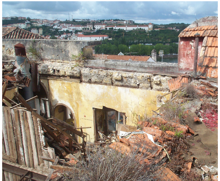
Fig.63 Vista interior da fachada principal
