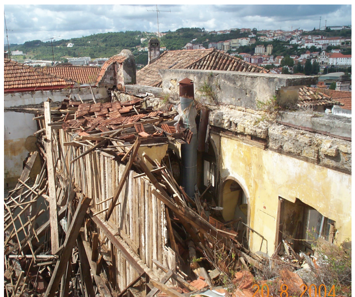
Fig.64 Vista interior da fachada principal
