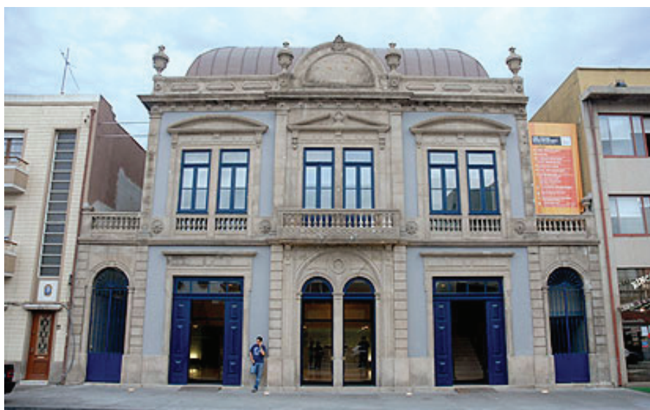
Fig.26 Fachada principal, após recuperação
