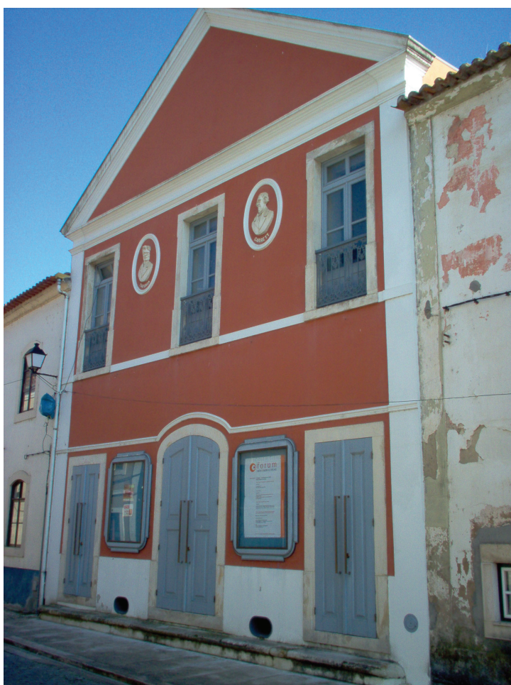
Fig.17 Vista da fachada principal
