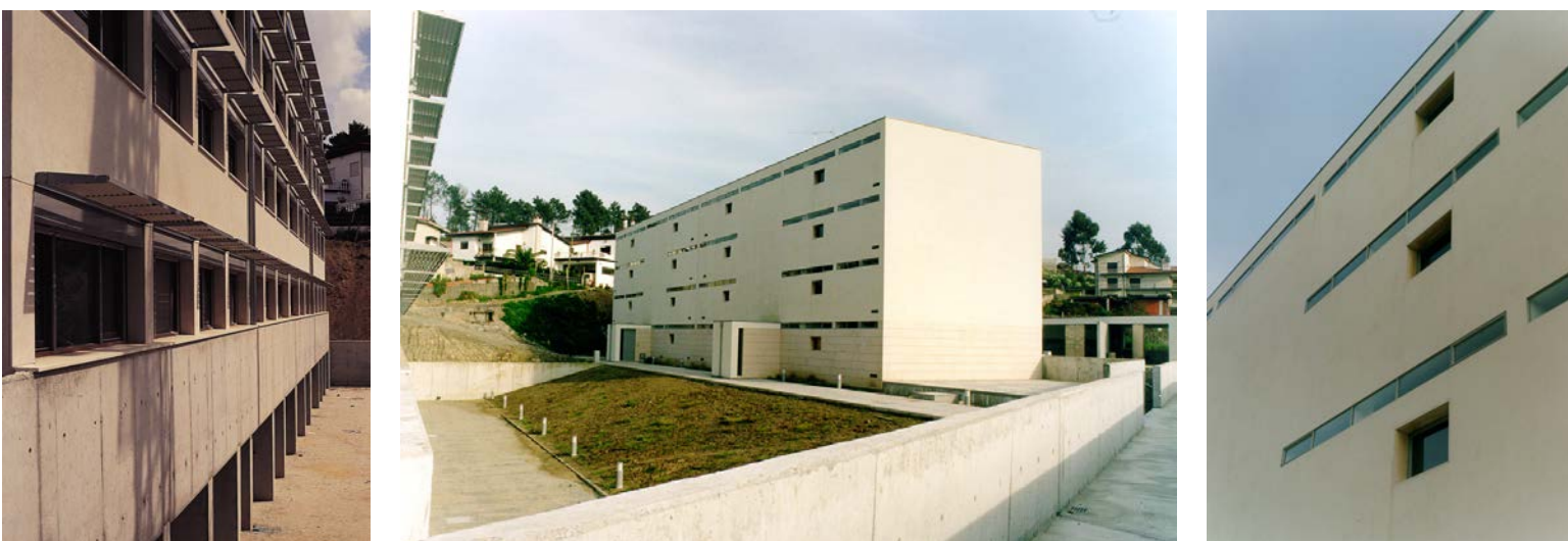
FIG. 86 - Fachada Sul, sistema de ensombreamento. Fachada Norte
