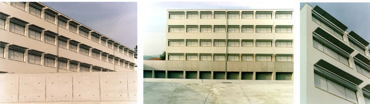
FIG. 85 - Fachada do quadrante Sul
