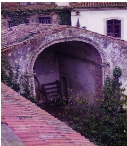
Ilustração 8 – Ruínas da Igreja da Misericórdia (vista de cima)
