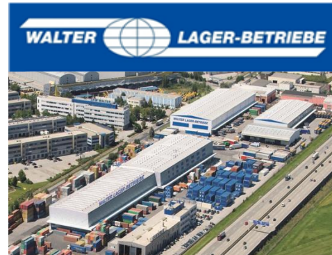
Figura 3 – Vista aérea da WALTER LAGER-BETRIEBE (Fonte: Site da LKW WALTER)
