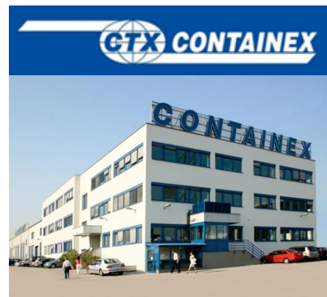
Figura 4 – Edifício da CONTAINEX (Fonte: Site da LKW WALTER)
