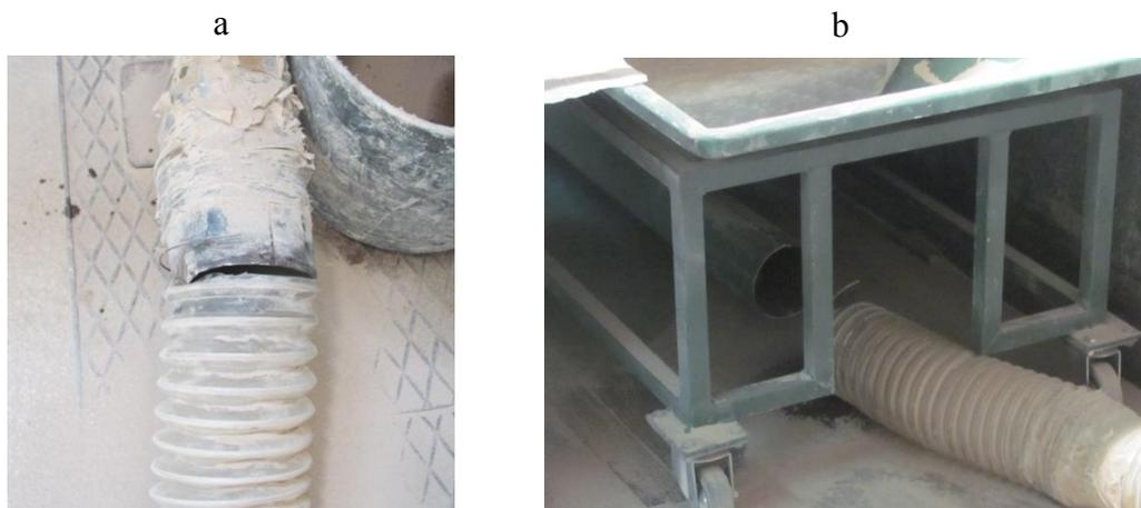
**Figura 34 - Conduitas mal acopladas ou desacopladas**
