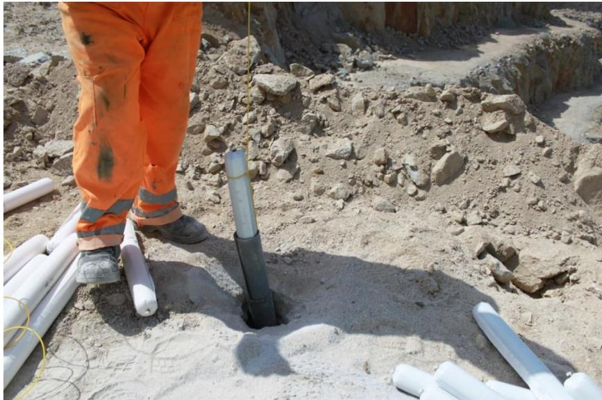
**Figura 3.7.** Carregamento da carga de fundo com o cabo eléctrico e o detonador incorporado.
