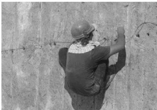
**Figura 3.9.** Aplicação de carga explosiva para realização do corte (Fonte: Regadas, 2006).
