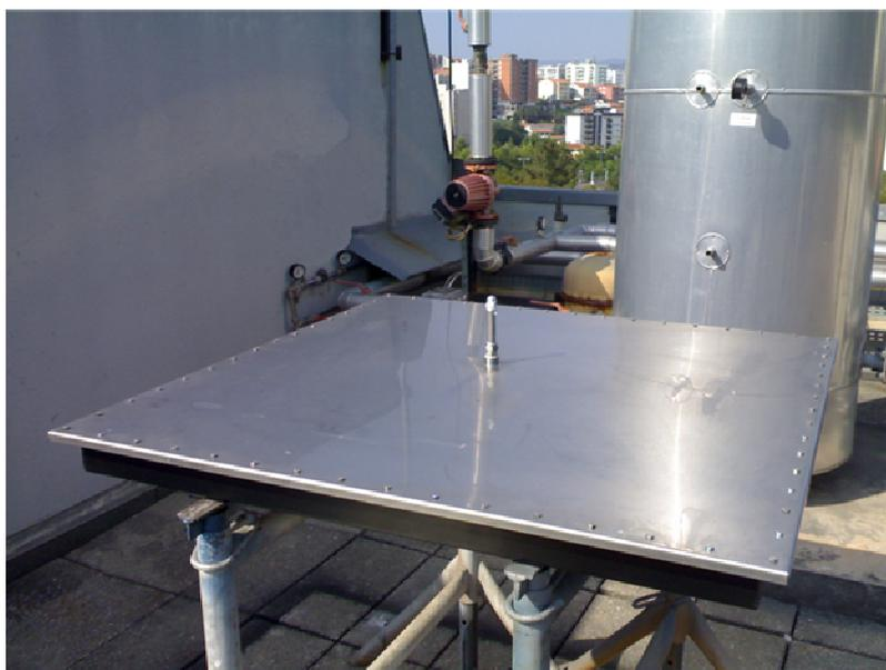
Fig. 11. Colector do frigorífico solar.
