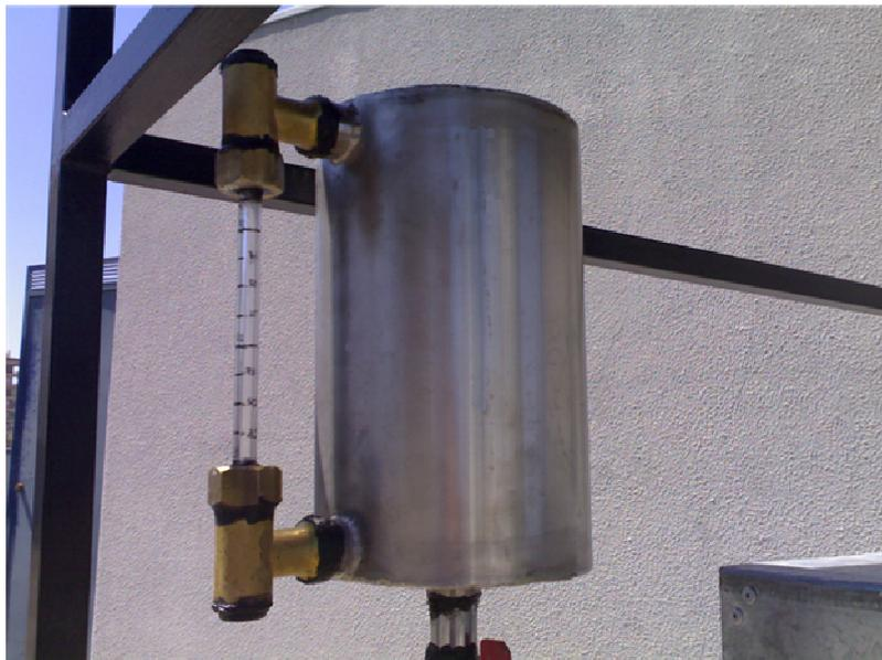
Fig. 15. Reservatório de condensados do frigorífico solar.
