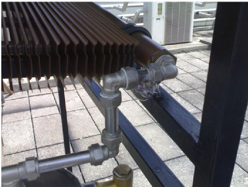
Fig. 21 - Exemplo de fuga detectada durante a realização dos testes de estanquidade.
