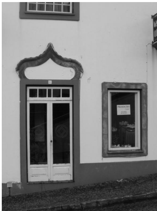
Moldura de porta na Rua do Salinas deixada a descoberto pelas obras de recuperação pós sismo de 1980. (foto: A. Reis Leite 2011)
