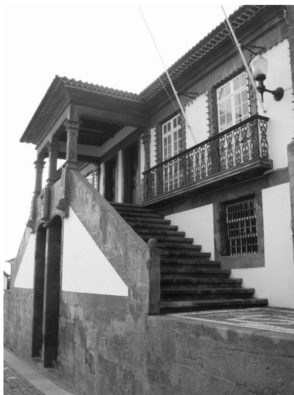
Edifício da Câmara da Praia. Escadaria de Acesso.
