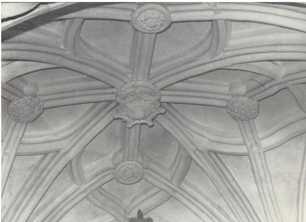
Uma das abóbadas da matriz que resistiu ao sismo de 1614 (e seguintes).
