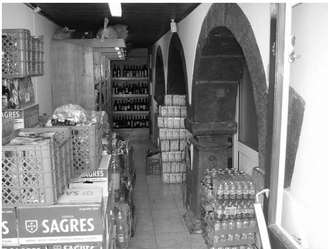
Restos de elementos construtivos do Convento da Luz, hoje transformado em armazém e espaço comercial.
