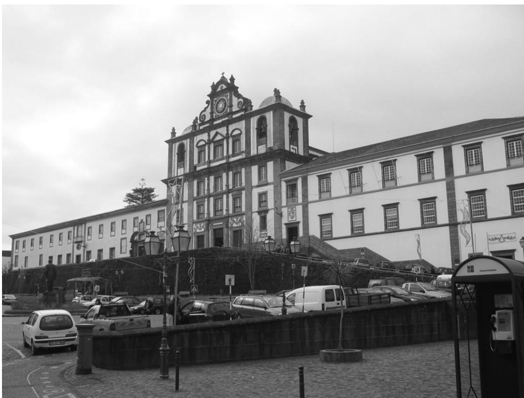
No lugar das Casas do Capitão construiu-se o Colégio dos Jesuítas.
