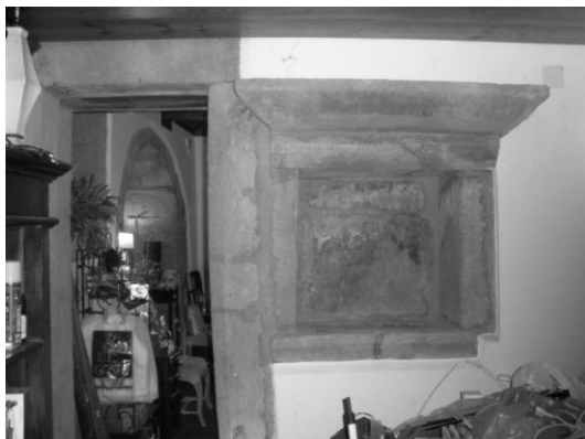
Vão de janela, entretanto fechado, inserido numa parede que primitivamente correspondia ao alçado tardoz de casa na Rua da Palha. (foto: A. Reis Leite 2011)
