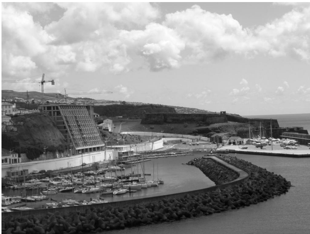
Vista do Forte de São Sebastião e porto Pipas a partir da Rocha.
