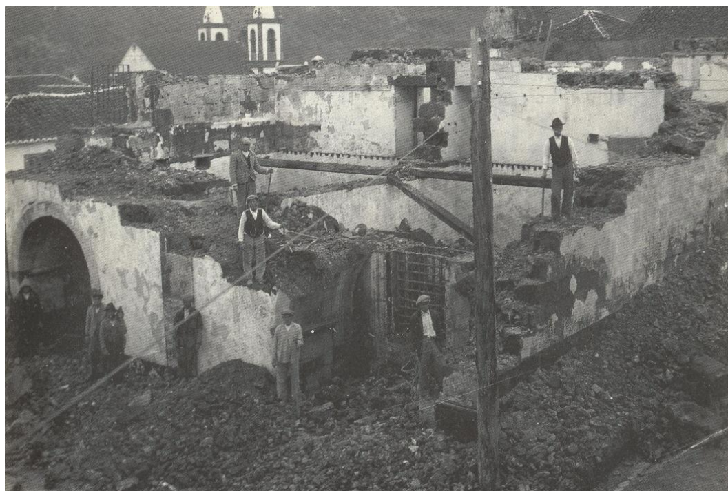
Obras de demolição da cadeia da Praia. [anos 50]
