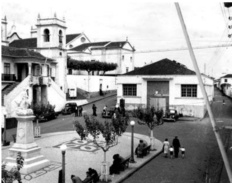
Fotografia da Praça da Praia depois de demolida a cadeia a escadaria que dava acesso à Rua de São Paulo, ainda visível na primeira fotografia mostarda do edifício camarário, com a escadaria e o chafariz adossado à cadeia.
