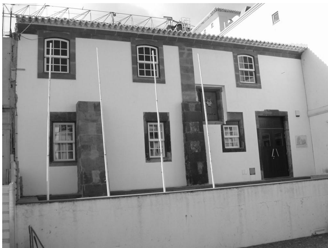
Obras de reabilitação das ruínas do Convento de São Francisco seiscentista.
