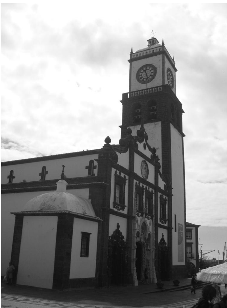
A igreja Matriz de São Sebastião, vista a partir do norte.
