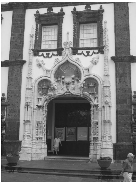
Portal da Matriz de São Sebastião
