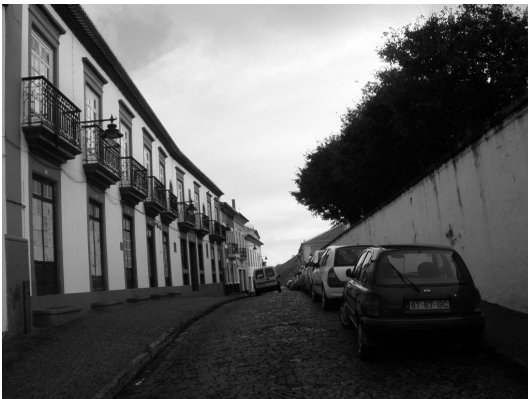
Vista norte-sul da Rua do Salinas, à direita o muro de suporte do adro da Sé.
