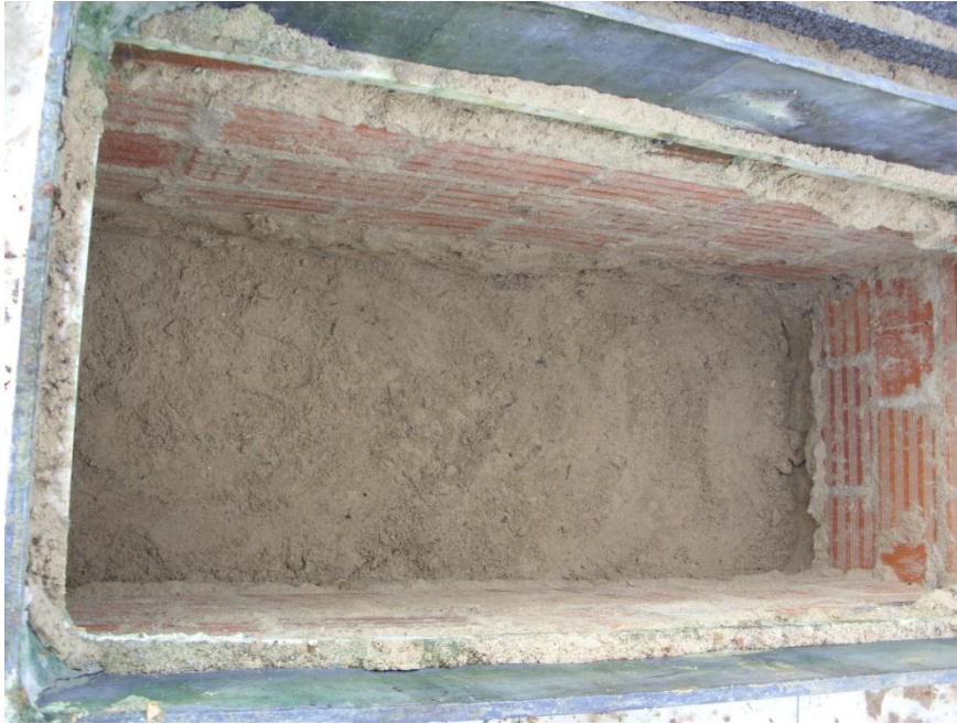
Figura 4.2 -Aspecto do interior de uma das sepulturas construídas com paredes em tijolo e colmatadas com areia (Cemitério Oriental da Figueira da Foz).
