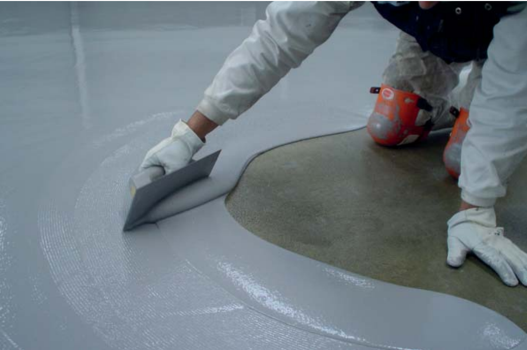
[Fig. 63] Piso auto-nivelante a ser aplicado.
