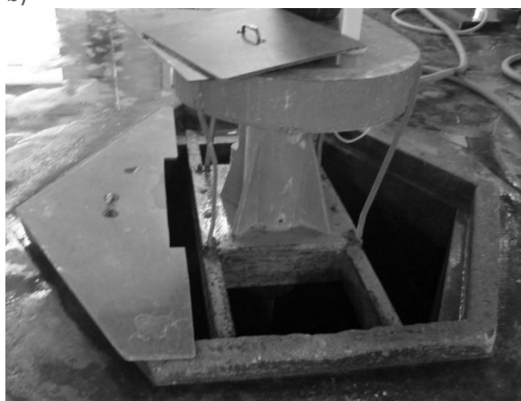
Figura 2.7: Depósito subterrâneo em betão para armazenamento, com agitação contínua da suspensão, a) representação esquemática, b) fotografia.
