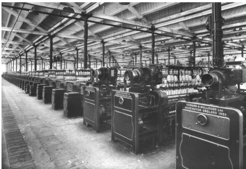
76. Sala de máquinas de fição Fotografia Alvão, [década de 40 do século XX]
