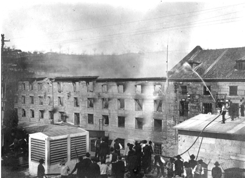
Incêndio da Fábrica de Fiação do Rio Vizela Fotografia Alvão, 1911
