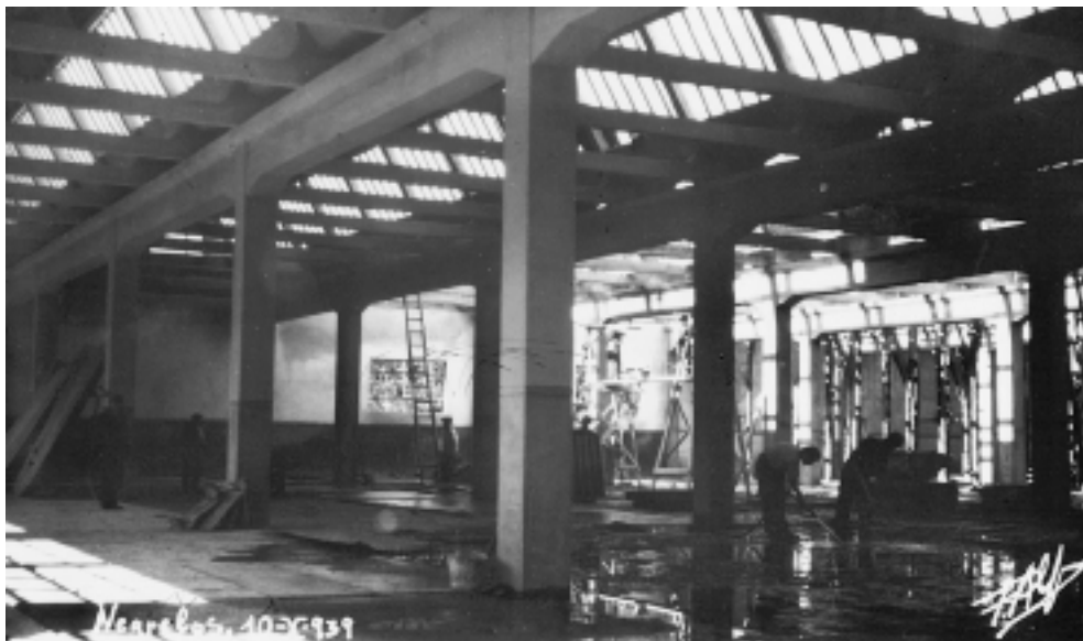
45. [Obras de construção da Fábrica de Fiação e Tecidos do Rio Vizela] Fotografia Alvão, 1939
