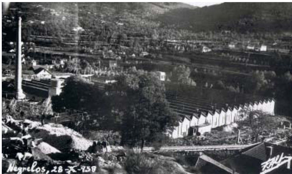
47. [Obras de construção da Fábrica de Fiação e Tecidos do Rio Vizela] Fotografia Alvão, 1939
