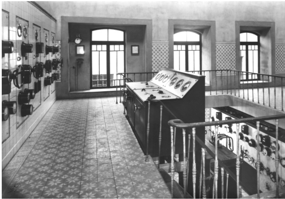
96. Sala de controlo de energia Fotografia Alvão, [década de 20-40 do século XX]
