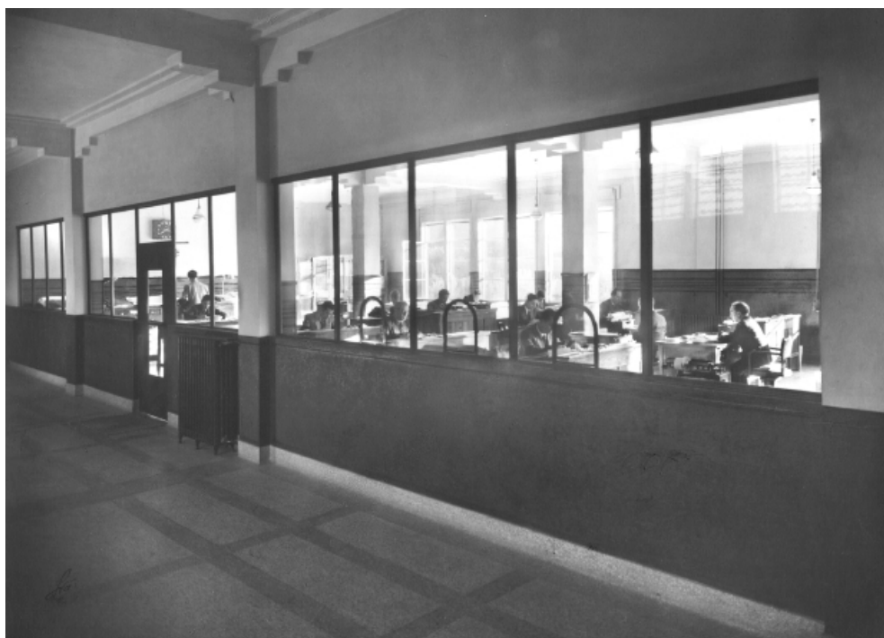
58. [Interior dos escritórios da Fábrica de Fiação e Tecidos do Rio Vizela] Fotografia Alvão, [década de 40 do século XX]
