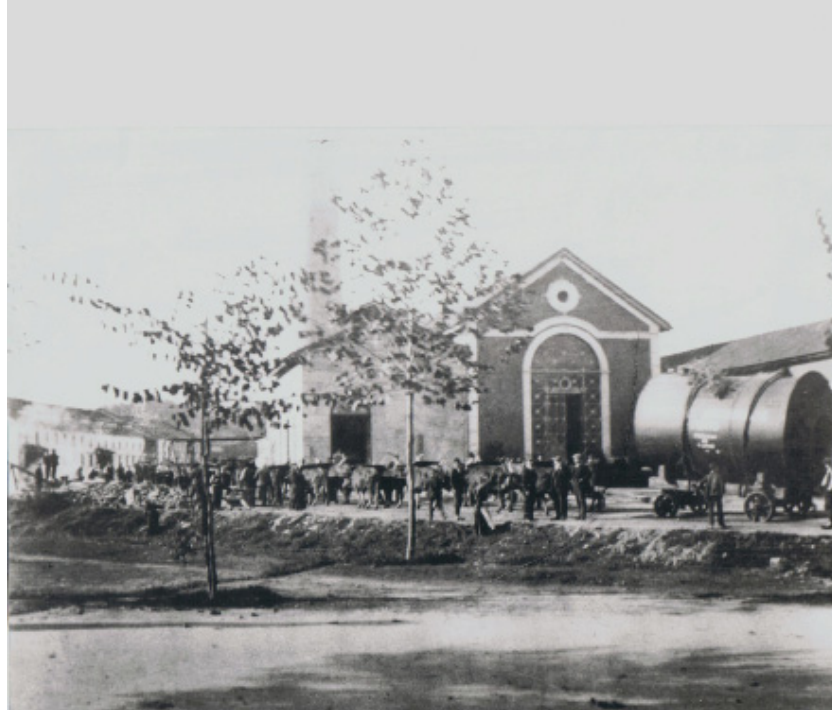
23. [Transporte de máquina a vapor para o edifício de tecelagem, margem direita] Fotografia Alvão, [década de 90 do século XIX]
