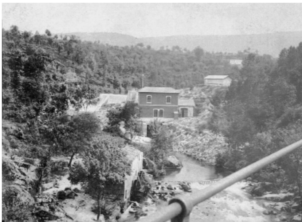
25. [Central Hidroelétrica, Caniços] Fotografia Alvão, [1908]
