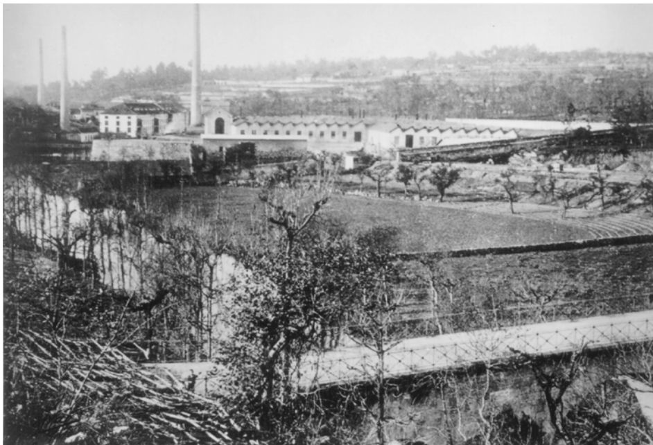
Vista geral da ponte sobre o rio Vizela, vendo-se a fábrica Fotografia Alvão, final do século XIX/início do século XX
