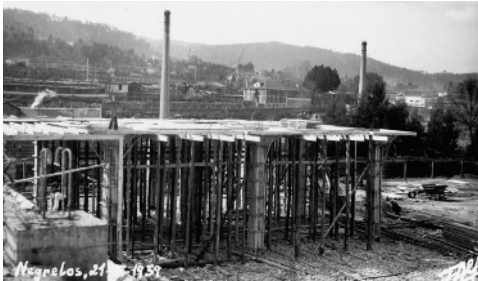
46. [Obras de construção da Fábrica de Fiação e Tecidos do Rio Vizela] Fotografia Alvão, 1939
