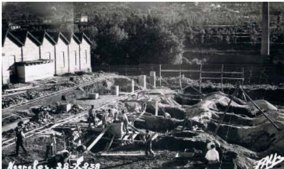
41. [Obras de construção da Fábrica de Fiação e Tecidos do Rio Vizela] Fotografia Alvão, 1939
