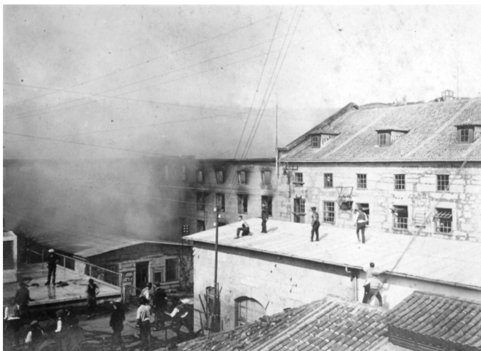
32. Incêndio da Fábrica de Fiação do Rio Vizela Fotografia Alvão, 1911
