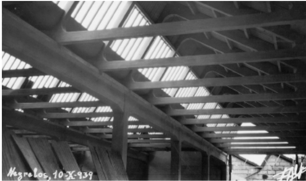
44. [Obras de construção da Fábrica de Fiação e Tecidos do Rio Vizela] Fotografia Alvão, 1939
