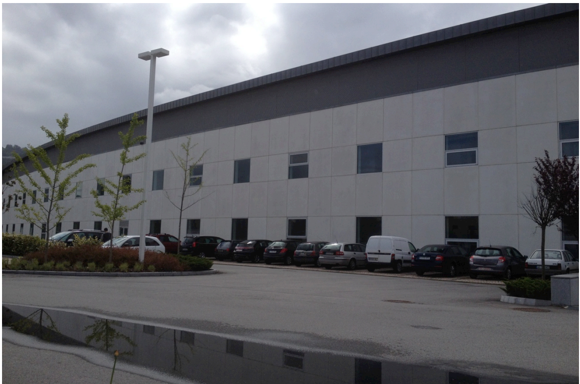
Figura 10 - Fachada lateral do INL (Foto do autor)
