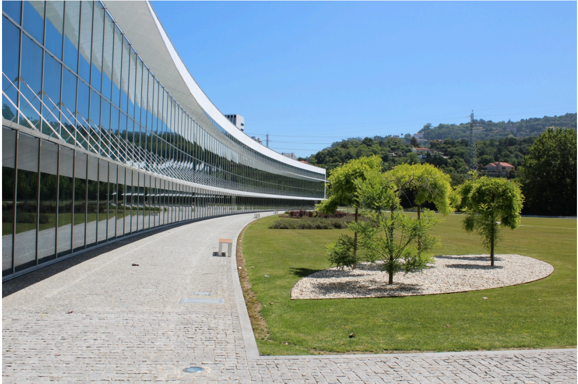
Figura 9 - Fachada interna do INL (Foto do autor)
