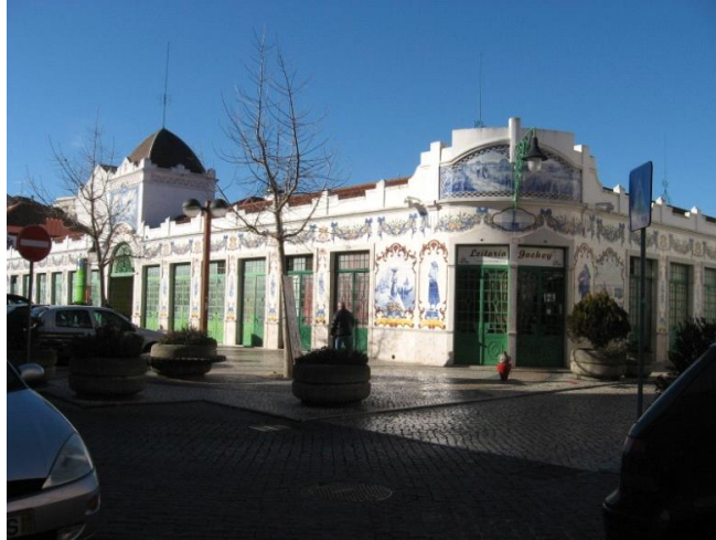
Figura 25 – Edifício do Mercado Municipal de Vila Franca de Xira
