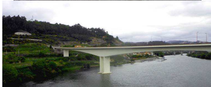
Imagem 18. A Nova Ponte sobre o Rio Douro
