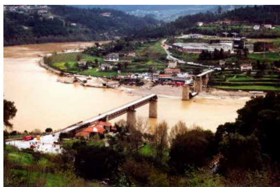
Imagem 10. Vista aérea da ponte Hintze Ribeiro pós-colapso, com a curva do rio do lado esquerdo da imagem
