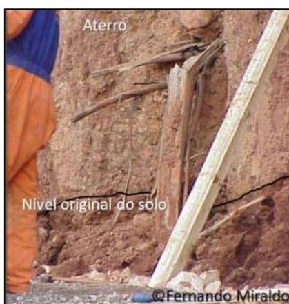
Figura 8 – Nível do terreno natural antes da deposição dos materiais do aterro. É visível, *in situ*, um tronco de árvore (anotado sobre fotografia cedida por F. Miraldo).
