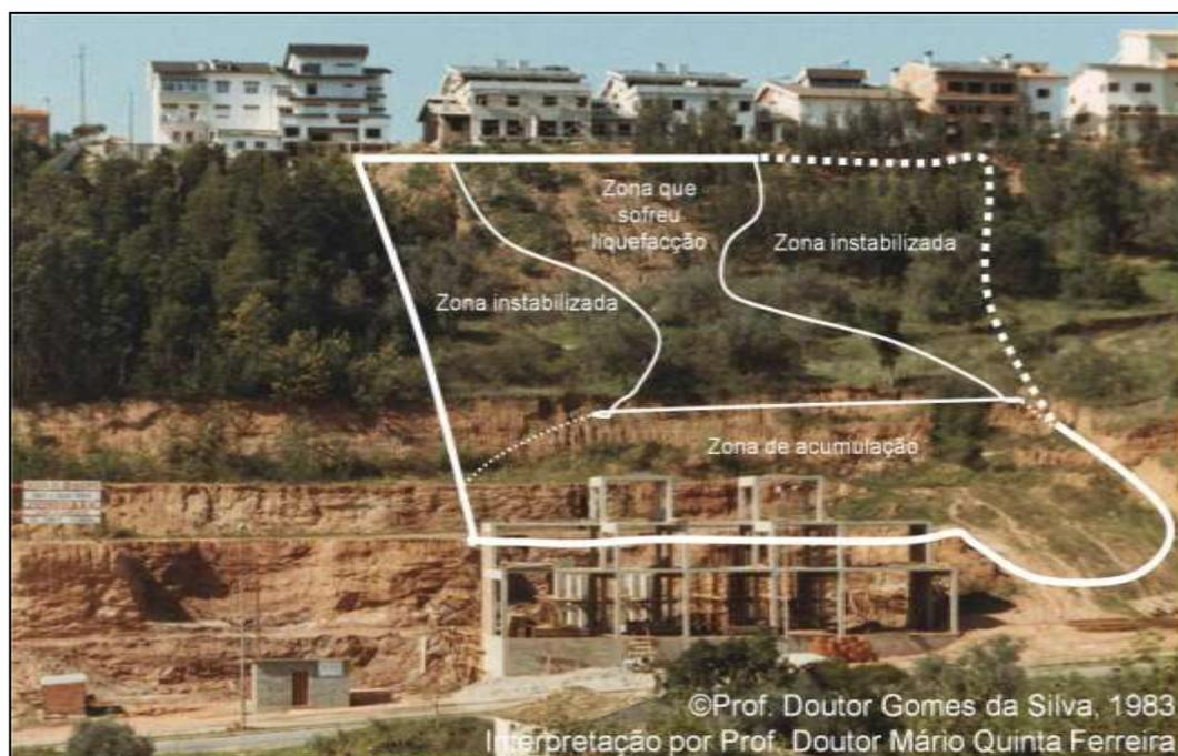
Figura 5 – Aspeto da vertente entre a Rua António Jardim e a Avenida Elísio de Moura, em 1983. Observa-se o prédio, afetado pelo deslizamento, em construção. São assinaladas as zonas que sofreram instabilização (fotografia cedida por F. Gomes da Silva e anotada por M. Quinta-Ferreira).
