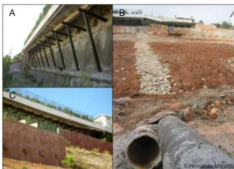
Figura 9 – Medidas de consolidação tomadas após o deslizamento de 27 de dezembro de 2000. A – Triângulos de suporte. B – Drenos (fotografia cedida por F. Miraldo). C – Muros com ancoragens.
