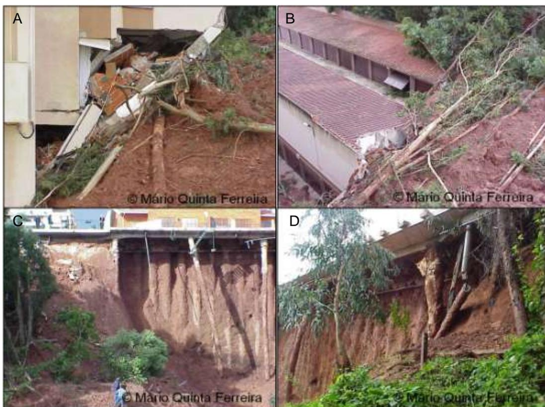
Figura 6 – Algumas consequências do deslizamento de 27 de dezembro de 2000 (fotografias cedidas por M. Quinta-Ferreira). A – destruição dos andares de um edifício da Avenida Elísio de Moura. B – Destruição de garagens; C – Cortina de estacas ancoradas, construídas aquando da estabilização de 1998, visíveis. D – Microestacas partidas.
