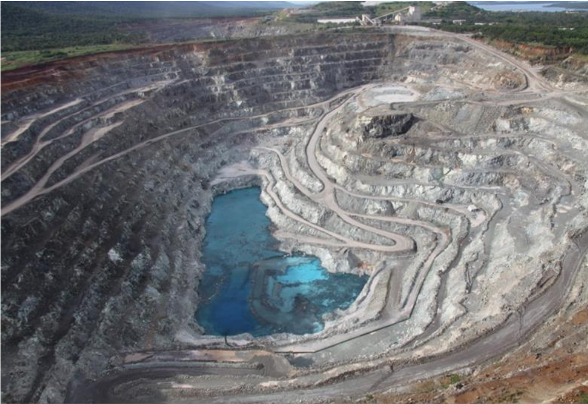
Figura 8 – Cava A — mina de Cana Brava
