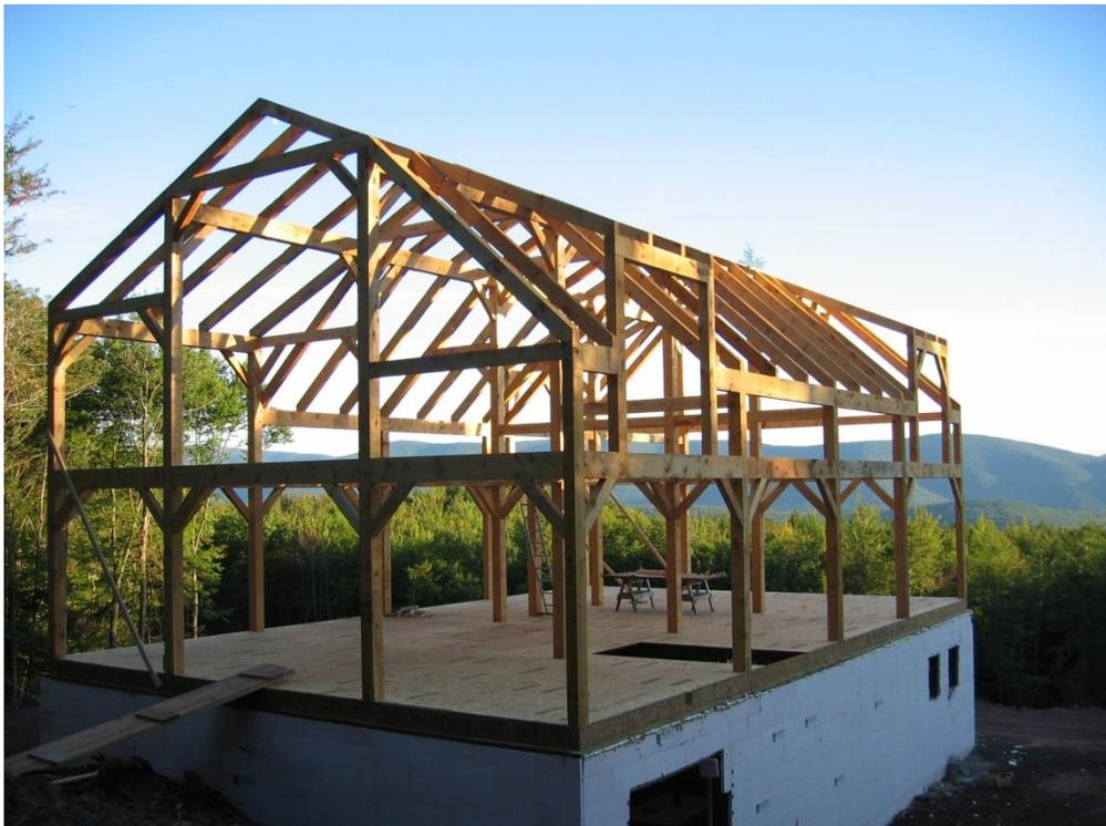
**Fig. 25** – Estrutura independente dos paramentos / “light-framing”
