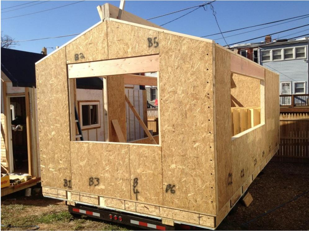
**Fig. 24** – Sistema de paredes autoportantes
