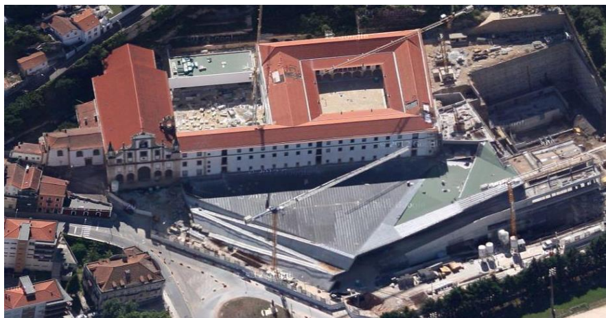
Figura 26 – Centro de Congressos e Convento de São Francisco
