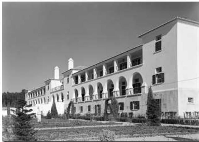
Fig. 1 Edifício do Hospital
