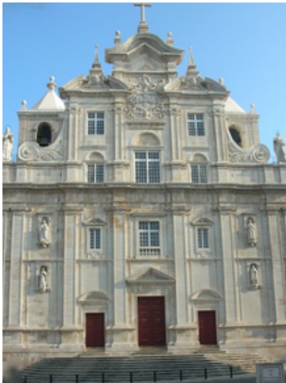
Figura 16: Fachada da Sé Nova - Antiga Igreja do Colégio de Jesus - Coimbra / Portugal Fonte: SIPA - Sistema de Informação para o Património Arquitectónico - Foto 00689530
