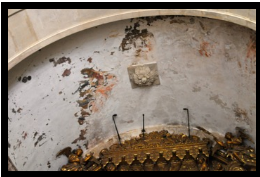
2. Pormenor da abóbada da Capela de Nossa Senhora das Neves Igreja do Colégio de Jesus de Coimbra (atual Sé Nova de Coimbra) Foto: RFP
