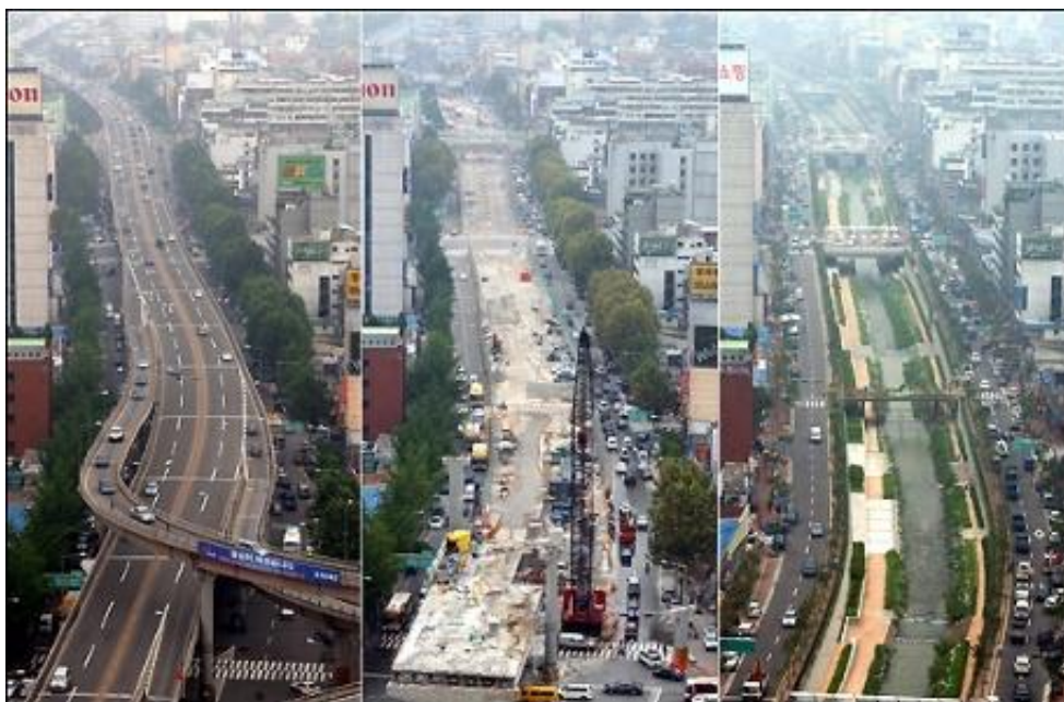
Figura 83 – Início das obras de recuperação do canal Cheonggyecheon
