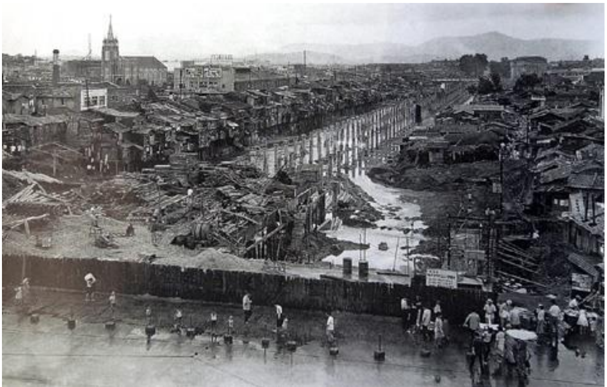
Figura 83 – Início da construção do viaduto sobre o canal Cheonggyecheon
